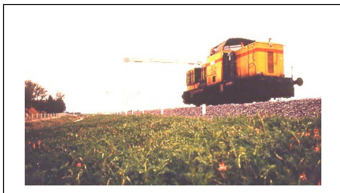
Interventi di idrosemina sulle scarpate della DD Roma-Firenze (AR), 1989. Dal monitoraggio (1988-2001) degli interventi di idrosemina è emerso che l'inerbimento iniziale a leguminose ha consentito la successione dinamica verso la vegetazione autoctona (Cornelini, 2001)(Foto P. Cornelini).
