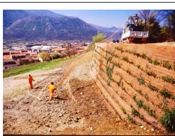
Intervento di idrosemina su terra rinforzata stradale. Atina (FR) 2001 (Foto P. Cornelini).
