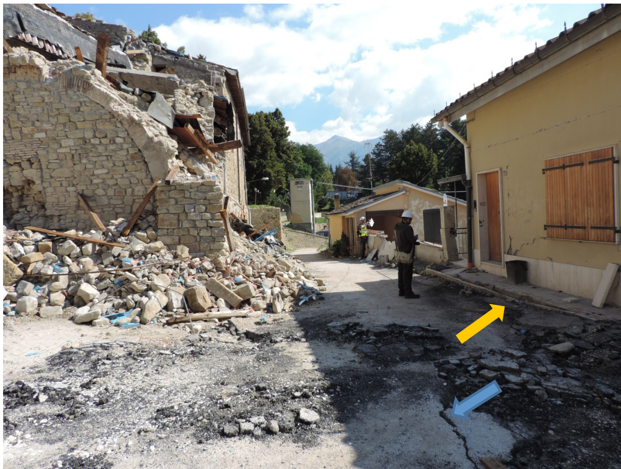
Foto 4 – Lesioni lungo Via Madonna della Porta (freccia azzurra). La freccia arancione indica la base dell'edificio che appare basculante.
