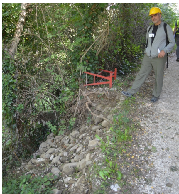
Foto 2 – Particolare di localizzati fenomeni di crollo cosismici dei paramenti di contenimento in area di sopralluogo.
