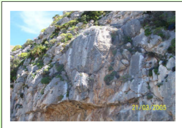
Elemento lapideo placcato con tiranti del tipo a bulbo iniettato
