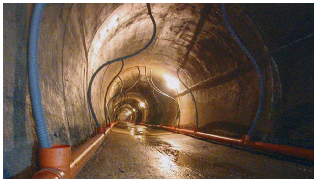
Gallerie drenanti e disposizione spaziale dei microdreni
