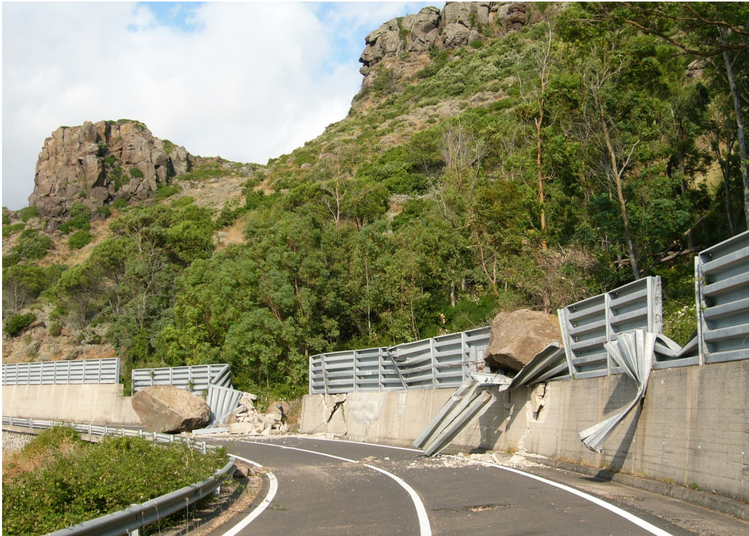
Fenomeni di crollo e ribaltamento di blocchi di litologie ignimbriche- Punta Spinosa Strada Statale n°134 (tratto Castelsardo-Sedini)
