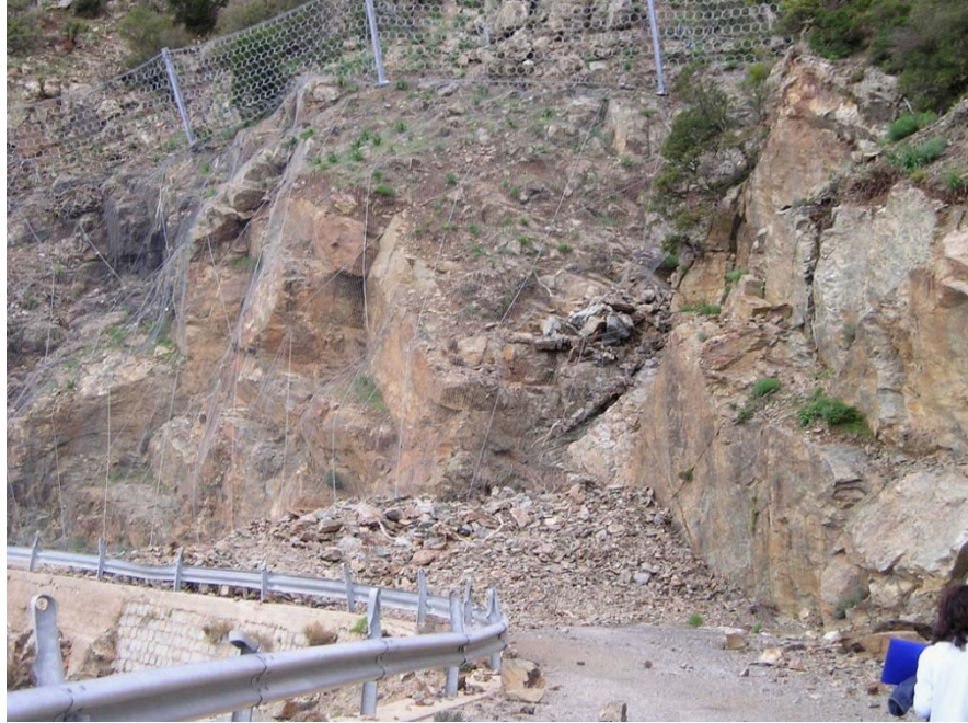
Frane complesse su metamorfiti e relativi detriti in Comune di Talana (NU)
