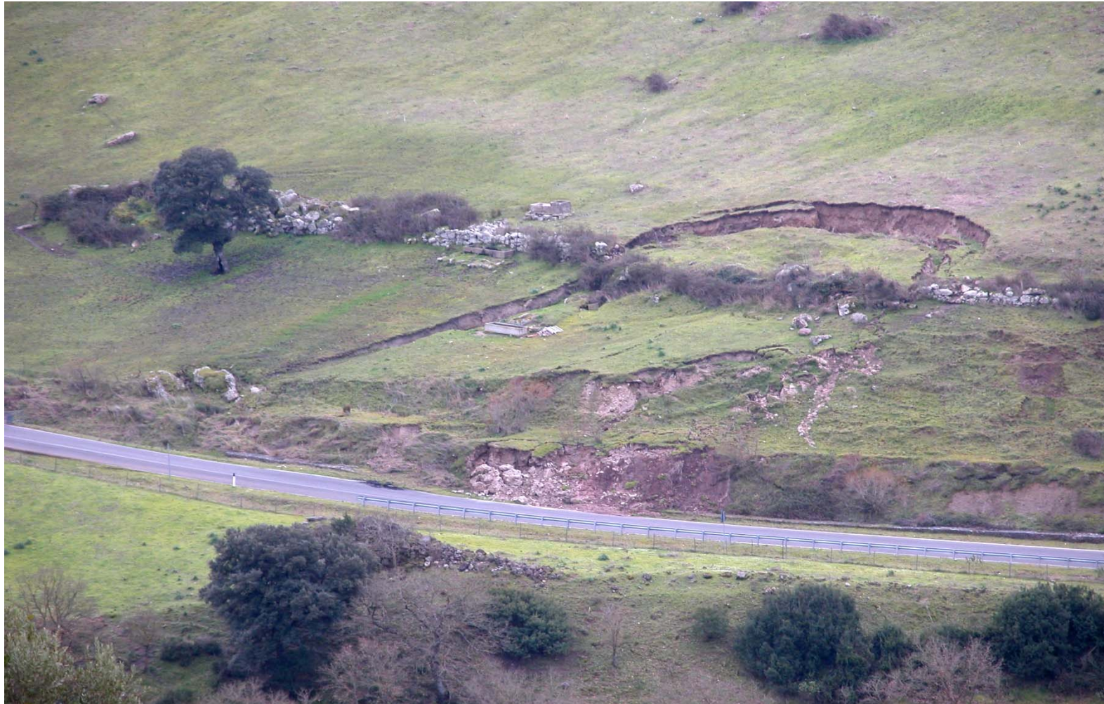
Fenomeni di scivolamento rotazionale a carico di depositi piroclastici e vulcanoclastici ridosso della strada Provinciale Allai –Samugheo - Comune di Ruinas (OR).
