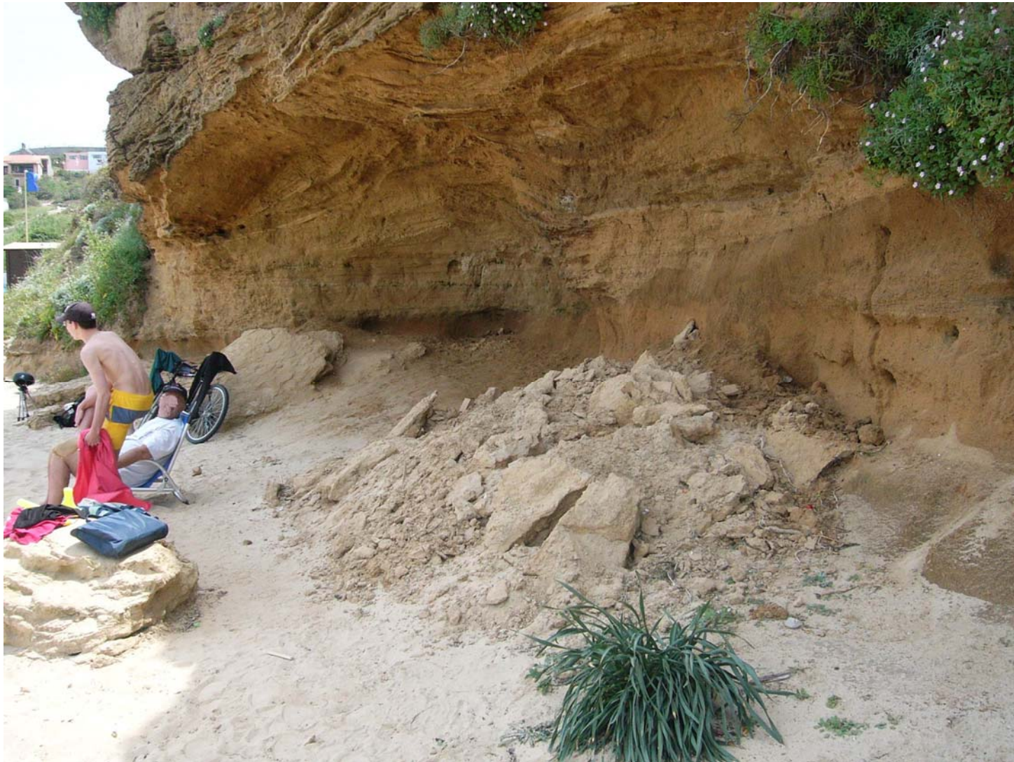
Area soggetta a crolli e ribaltamenti diffusi in arenarie eoliche Comune di Santa Teresa di Gallura — Spiaggia Rena Bianca
