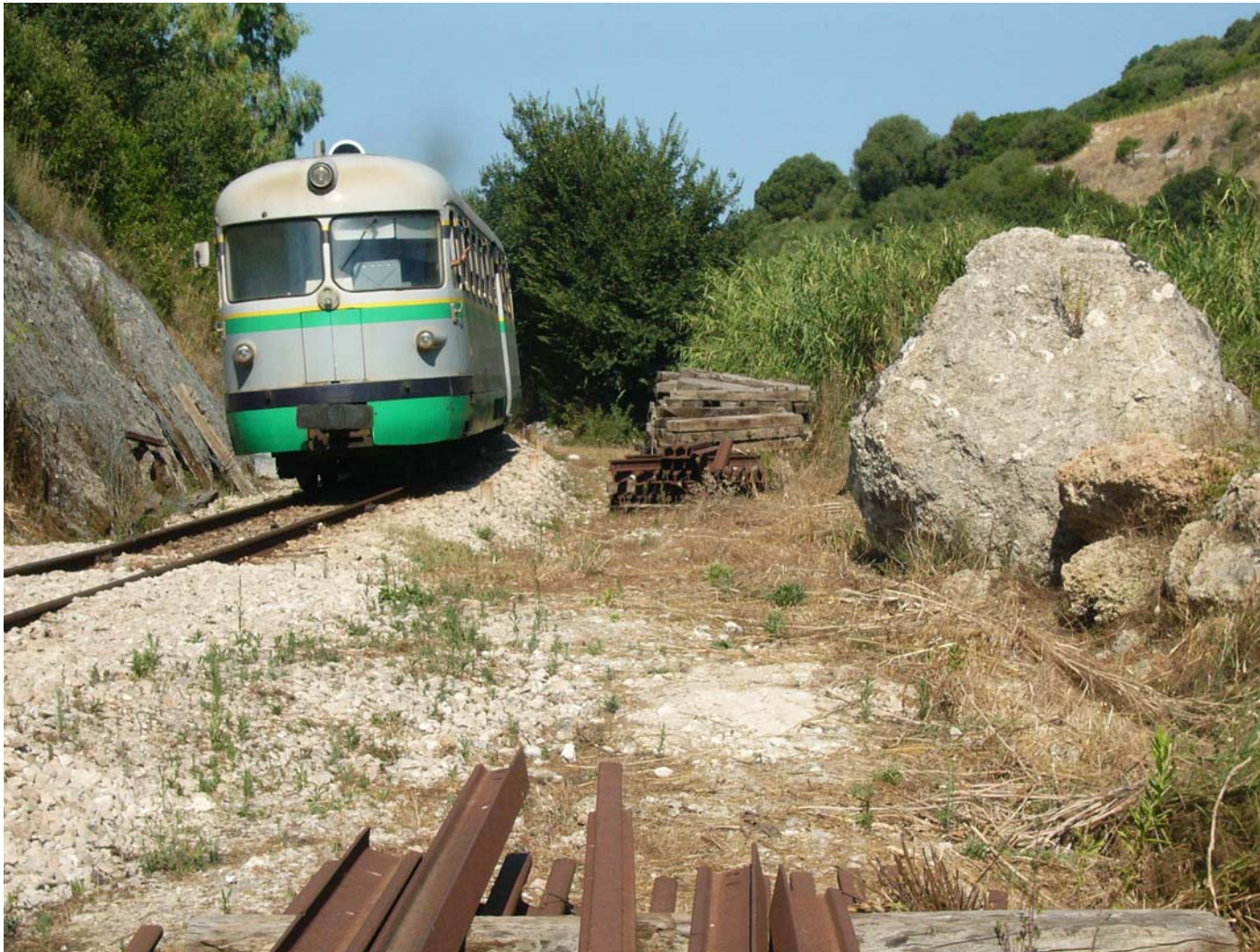
Fenomeno di crollo in litologie carbonatiche mioceniche - Comune di Usini (SS) - località Riu Mascari.
