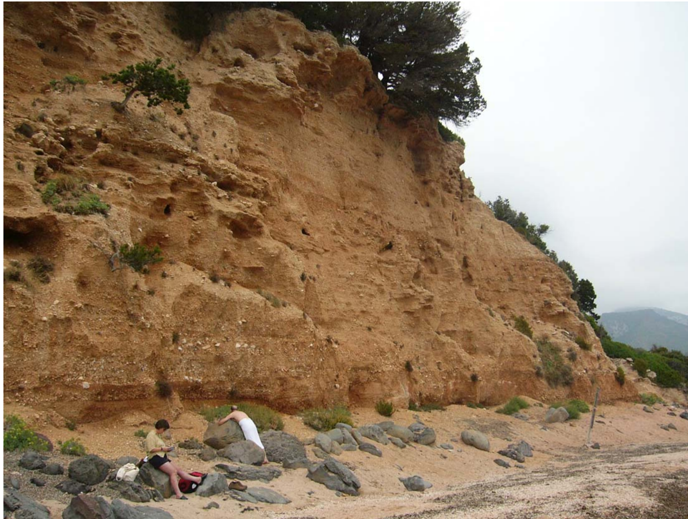
Area soggetta a crolli e ribaltamenti diffusi in conglomerati e brecce continentali - Comune di Dorgali, località Abba Meica.
