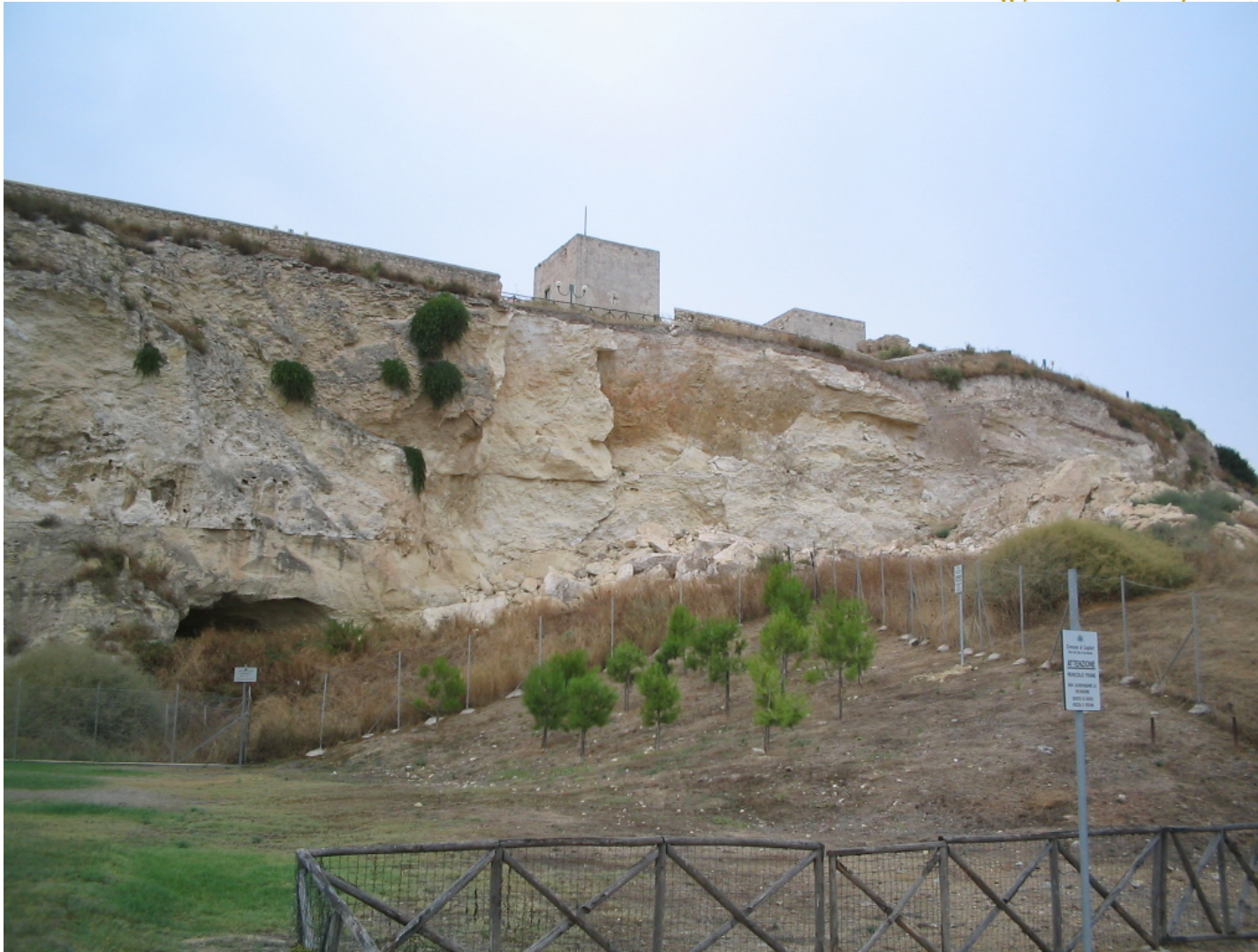
Fenomeni di crollo e ribaltamento in litologie carbonatiche in corrispondenza del Colle di S.Michele - Comune di Cagliari
