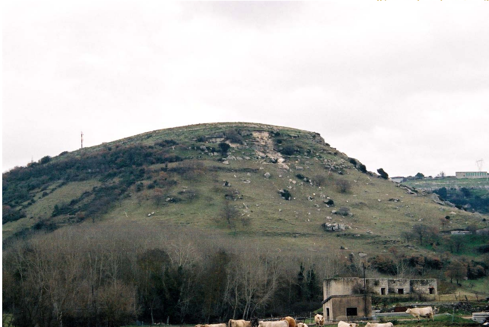
Fenomeni di crollo e ribaltamento su calcareniti sommitali in loc. Su Montisu – Comune di Thiesi
