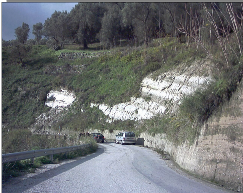
Palmi San Procopio (2003). Parete sub-verticale costituita da alternanze argilloso-marnose (con intercalazioni sabbiose) interessata da caduta di blocchi e colamenti superficiali.
