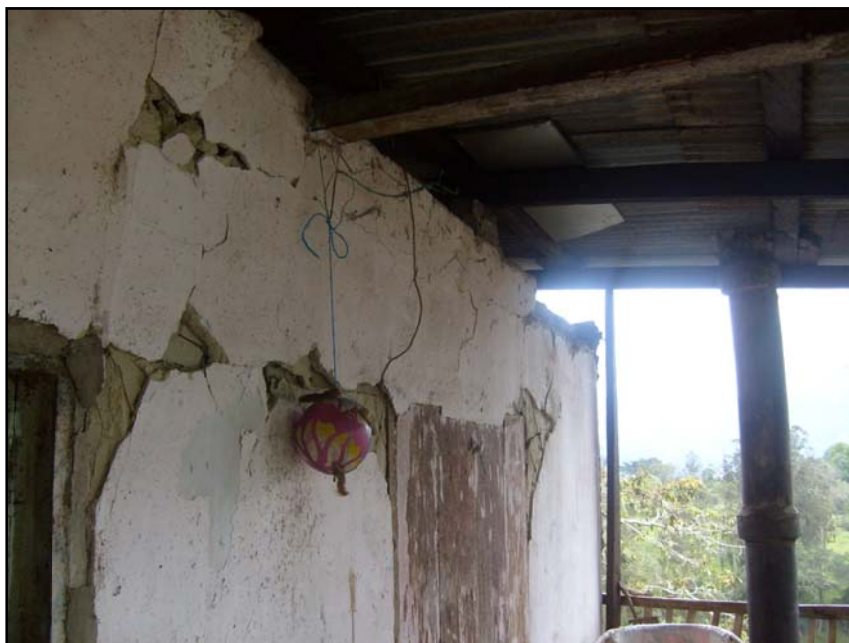
Fotografía 5.8. Daños en muros y techos en vivienda localizada en la Vereda Carrizal. Nótese el material de adobe con pañete de cemento superficial totalmente fisurado y susceptible a colapso.
