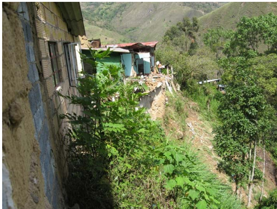
Fotografía 5.3 Daños en viviendas cercanas a los taludes y construidas en adobe
