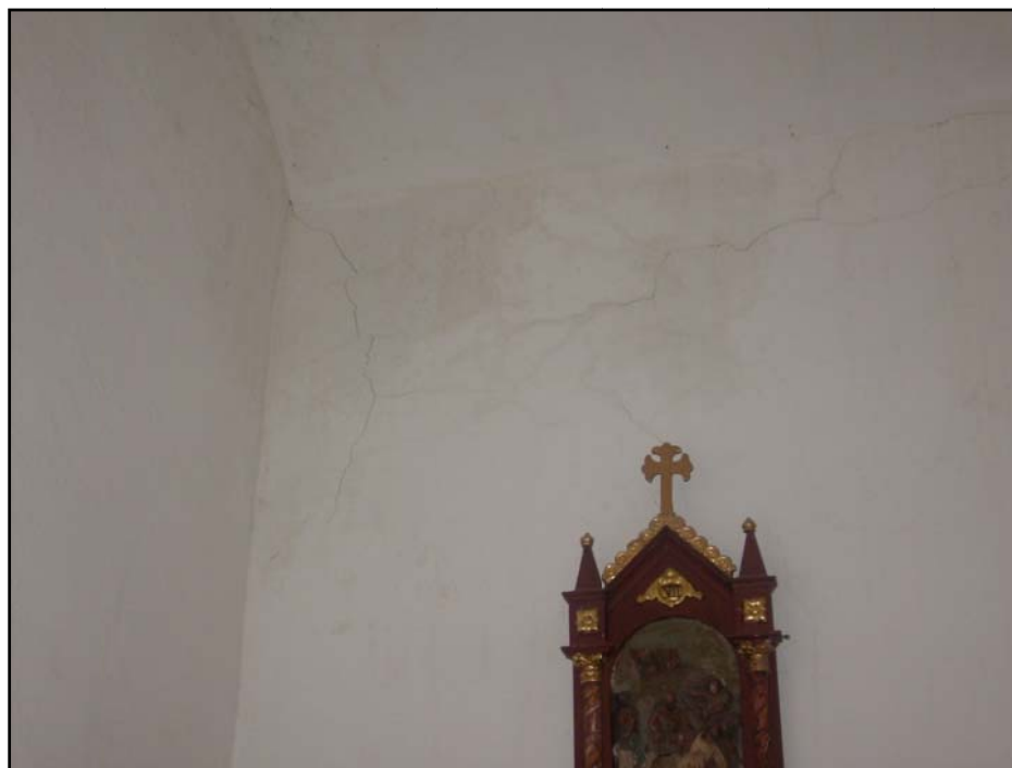
Fotografía 5.5. Detalle de fisuras observadas en el sector de la Cúpula de la Iglesia.
