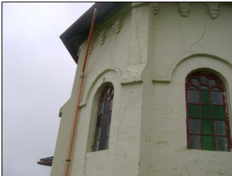
Fotografía 5.15: Grietas típicas en marcos de puertas y ventanas, San Juanito
