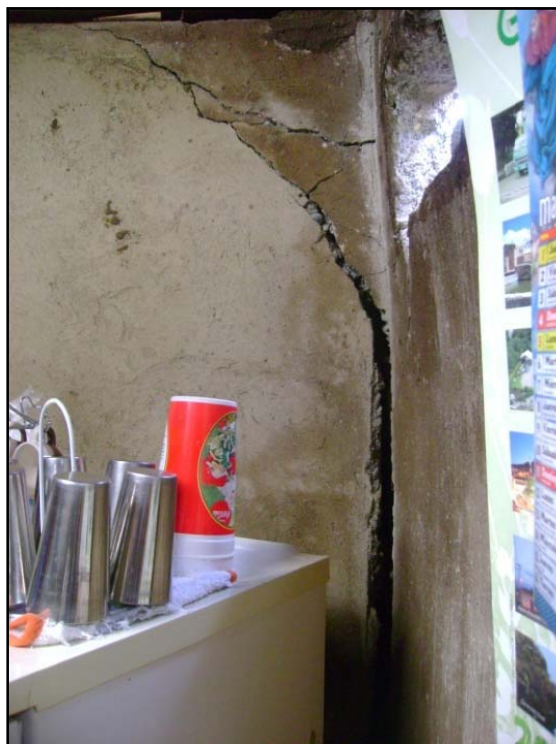
Fotografía 5.17: Desprendimiento de muros en zonas esquineras
