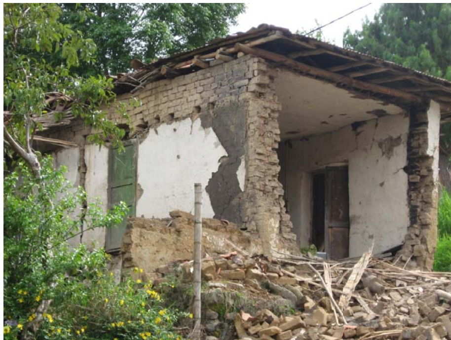
Fotografía 5.1. Vivienda en adobe totalmente fallada por el efecto del sismo.
