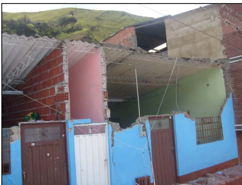
Fotografía 5.25. Colapso parcial de edificaciones en Pte. Quetame. Obsérvese las deficiencias de los sistemas constructivos.
