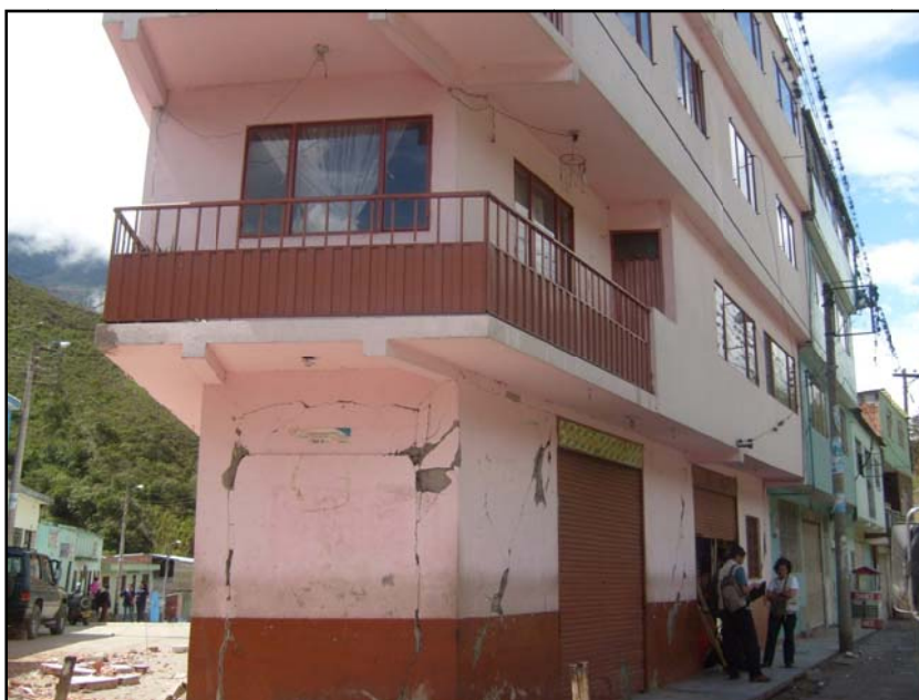
Fotografía 5.23. Daños severos en muros de vivienda localizada en Pte. Quetame. Obsérvese la geometría triangular de la edificación, lo cual la hace aún más vulnerable.
