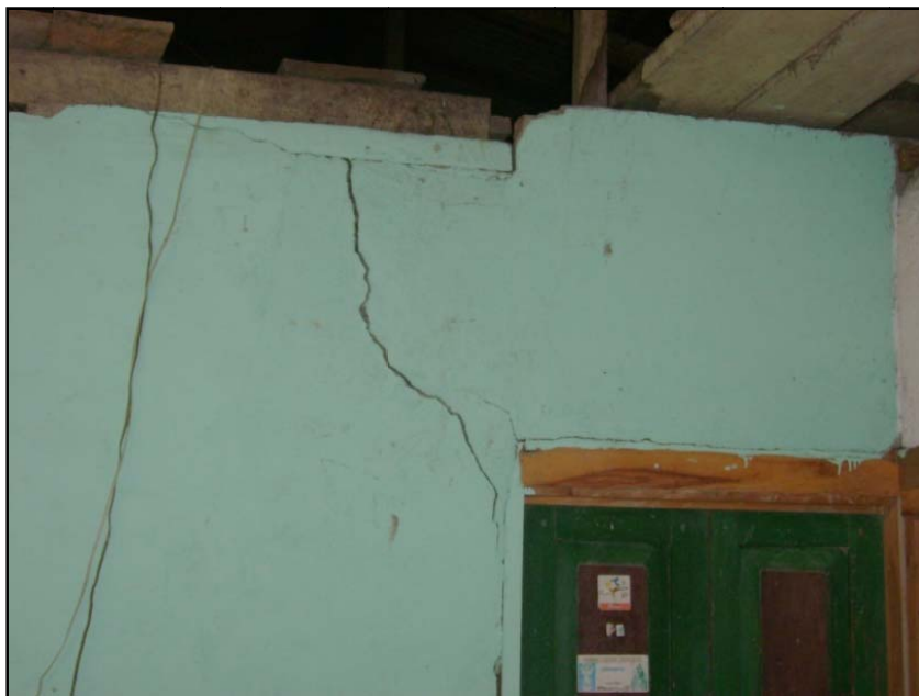
Fotografía 5.16: Fallas típicas por cortante en dinteles, San Juanito
