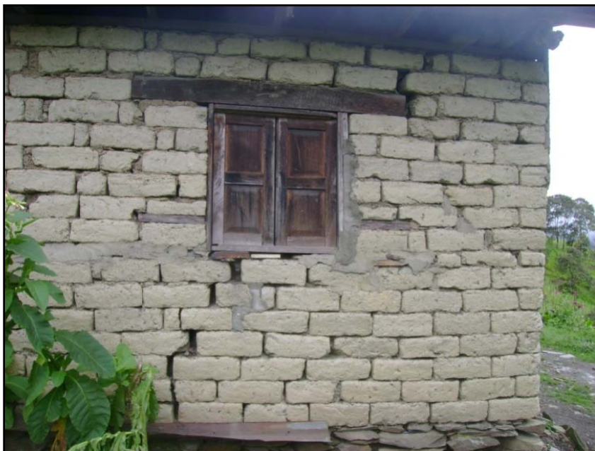
Fotografía 5.20: Deficiencias en materiales empleados, vereda El Carmen
