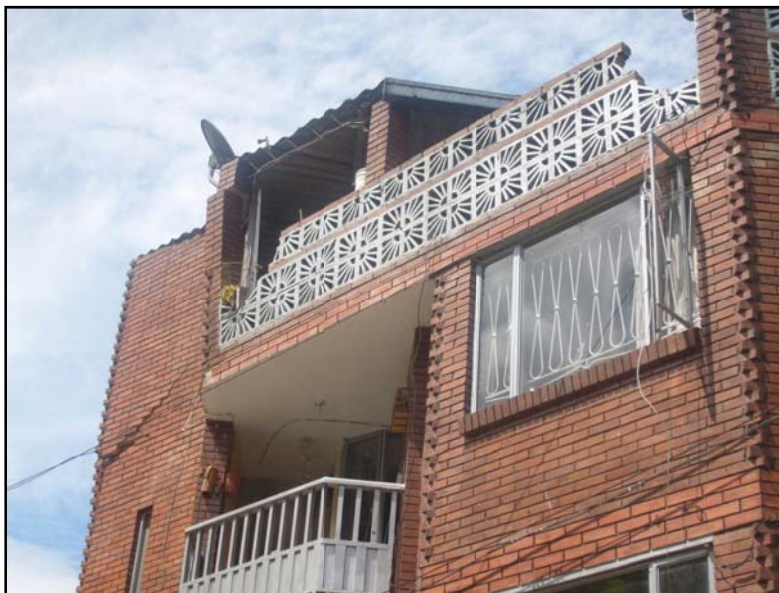
Fotografía 5.26. Daños severos en elementos estructurales. Obsérvese la falla en las columnetas del último piso.
