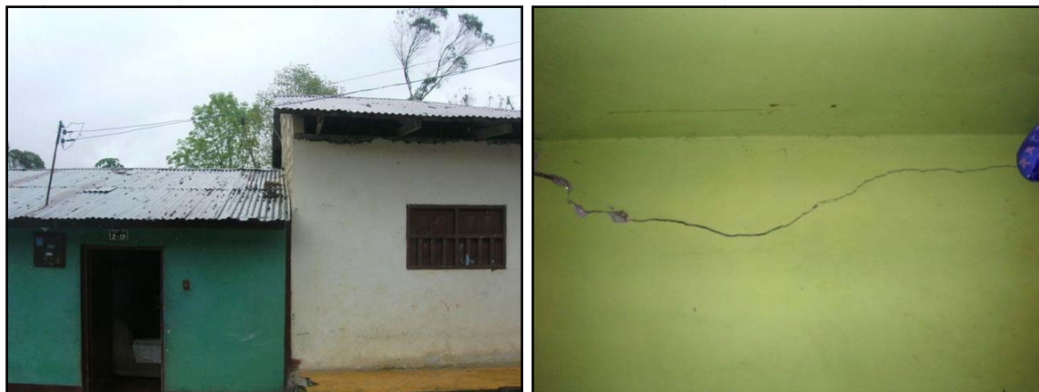
Fotografía 5.12. Casas junto a la plazoleta principal de la Inspección de Policía de San Francisco en donde se observaron casas con fisuras, grietas y un muro levemente inclinado en casa de ladrillo de adobe.
