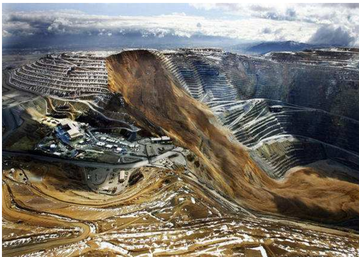
Figura 3.2 Miniera a cielo aperto per la coltivazione del rame negli USA, Utah. (Immagine tratta dal sito web http://blog.skytruth.org/2013/04/landslide-at-bingham-canyon-mine-utah.html )
