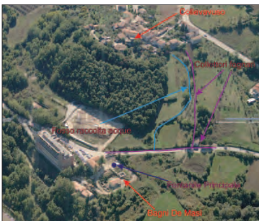
Figura SC.19.7 - Vista panoramica del sito "Bagni De Masi" con le indicazioni dei principali elementi di pressione antropica.
