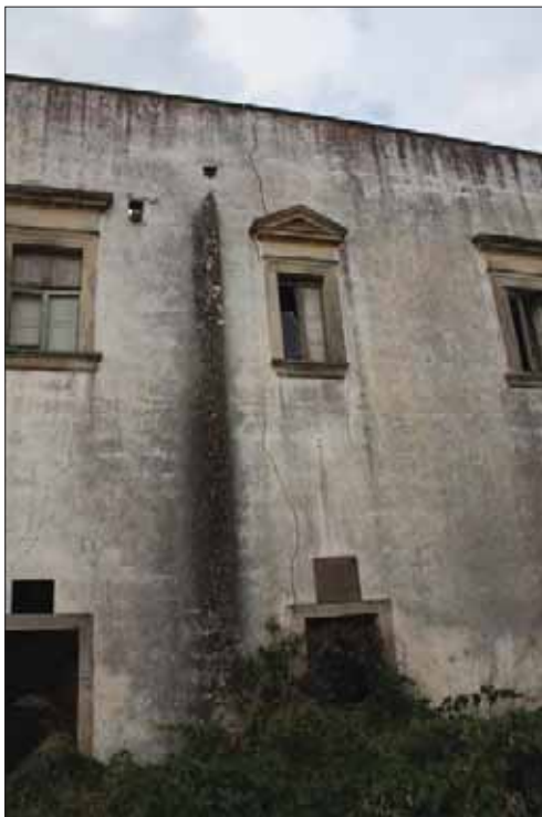
Fig. 6 - Evidenze delle fratture concentriche in esterno, e dei gradini all'interno dell'area interessata dal sinkhole.
