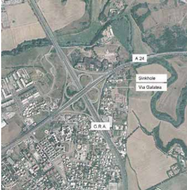
Fig. 5 - Localizzazione del sinkhole di Via Galatea.
