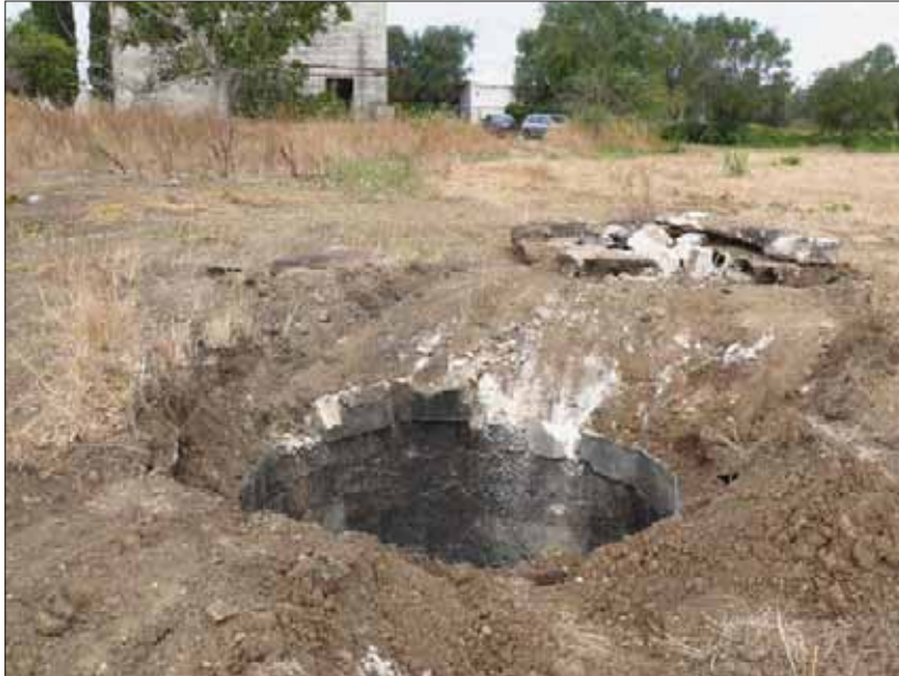
Fig. 9 – Boccapozzo sito nei pressi del sinkhole, poco a N di questo.
