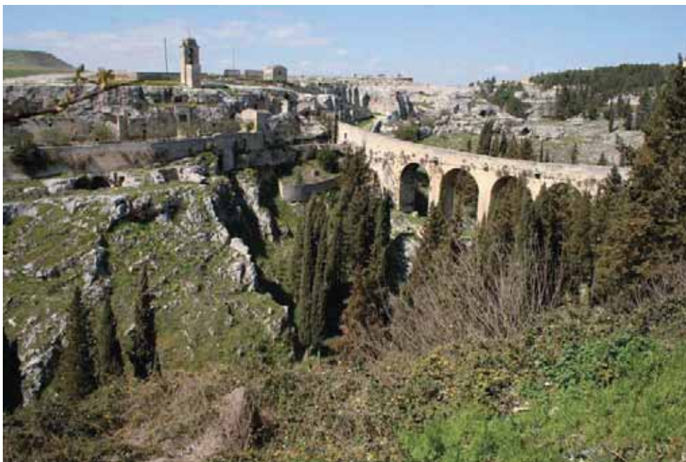
Fig. 6 – Cavità artificiali sui fianchi del Torrente Gravina, al margine occidentale del centro abitato di Gravina in Puglia. Il ponte-canale visibile a destra nella foto è la parte terminale dell'acquedotto "Sant'Angelo - Fontane della Stella" (Bixio et alii, 2007).
