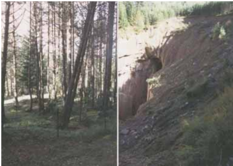
Fig. 12 - A sx: evidenze superficiali di inizio del fenomeno di richiamo per subsidenza da crollo: alberi reclinati all'interno del bacino. A dx: evoluzione finale del crollo: ancora chiaramente visibile la camera di coltivazione e la copertura rocciosa e detritica, quest'ultima a formare la scarpata.
