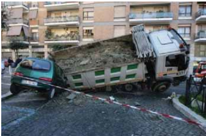
Fig. 5 - Voragine nel centro urbano di Roma presso la stazione S. Pietro, 22 dicembre 2008 (foto da www.iltempo.it ).
