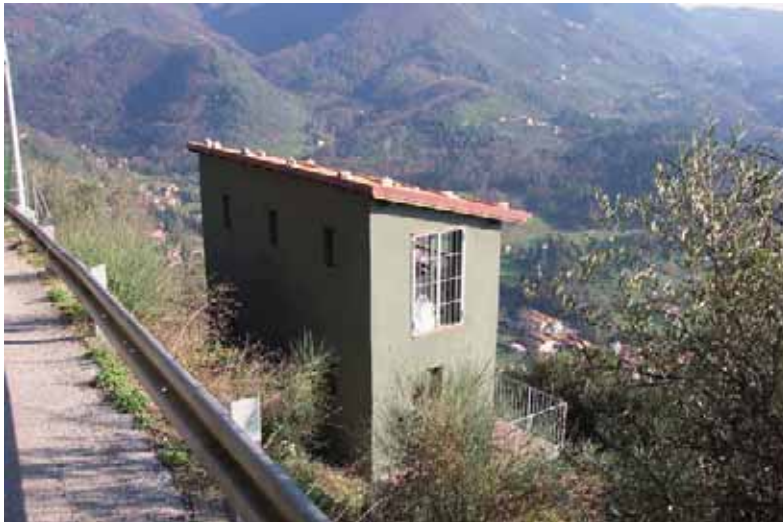
Fig. 3 - Foto della costruzione edificata in località Greppolungo per ospitare il sistema GBInSAR LiSALab e gli apparati elettronici ad esso connessi. A partire da Febbraio 2007 il sistema misura in continuo gli spostamenti superficiali del terreno della piana di Camaione.
