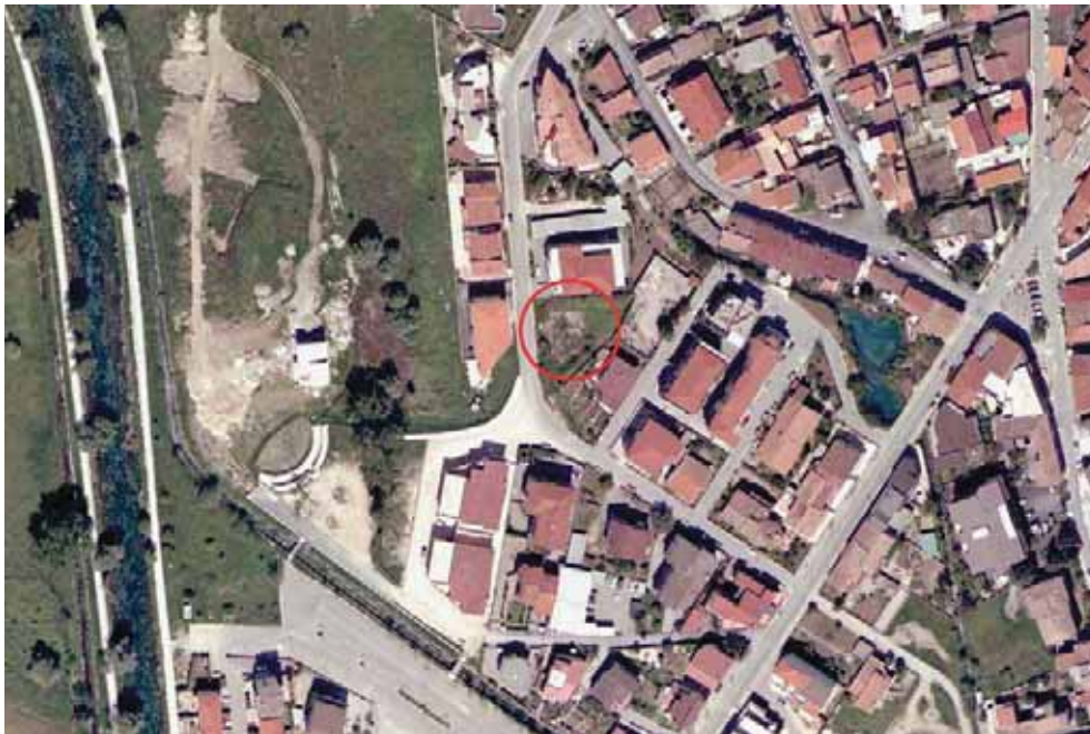
Fig. 2 - Telese T. - Area dello sprofondamento del 7 febbraio 2002
