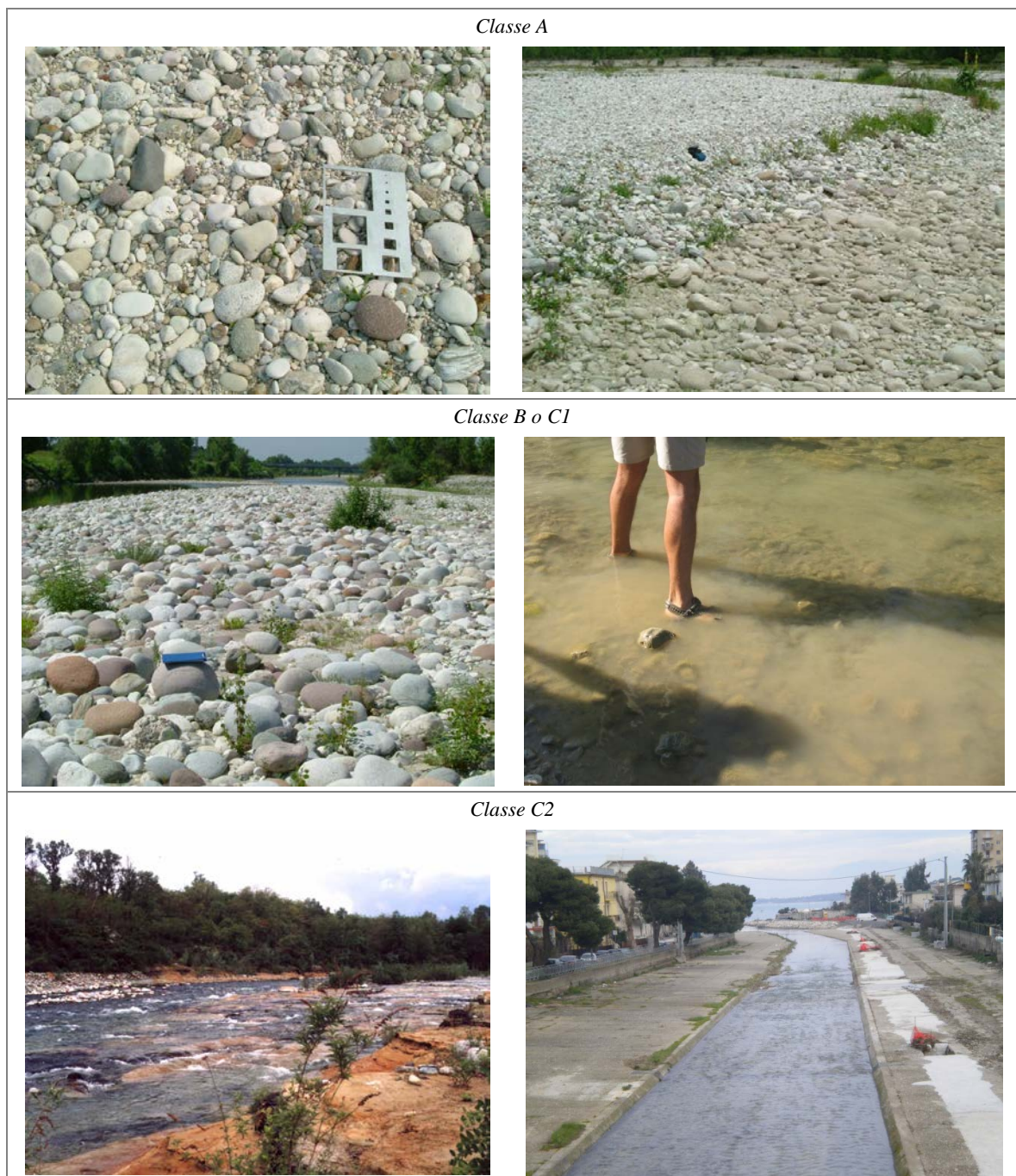
Figura A4.44 – Alterazioni del substrato in alvei semi- e non confinati. Classe A : naturale eterogeneità dei sedimenti in un alveo non confinato. Classe B o C1 : presenza di corazzamento (foto a sinistra) o clogging (foto a destra) (l'attribuzione alla Classe B o C1 dipende dall'estensione del fenomeno nel sito di indagine). Classe C2 : alveo con substrato affiorante a causa di incisione del fondo (foto a sinistra) o alveo con fondo completamente rivestito (foto a destra).
