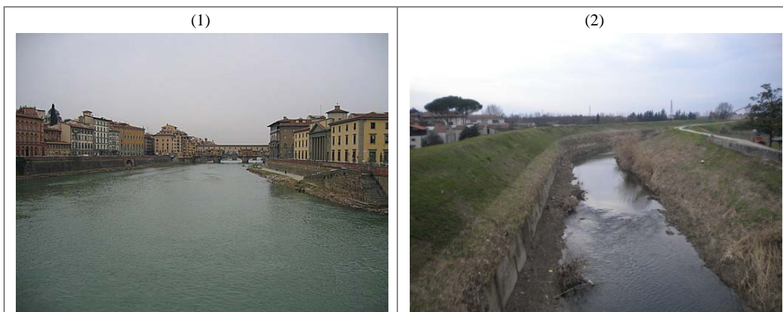
Figura A4.70 – Casi di difese di sponda – argini a contatto che interessano il tratto quasi per la sua interezza (> 80%), per i quali si applica quindi una penalità aggiuntiva di 12 .
