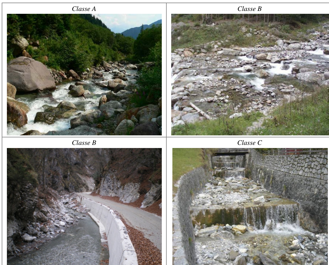
Figura A4.39 – Variabilità della sezione in alvei confinati. Classe A : assenza di alterazioni della naturale eterogeneità della sezione. Classe B (in alto a destra): alterazioni per una porzione limitata del tratto. Classe B (foto in basso a sinistra): alterazioni per una parte predominante del tratto (> 66%) ma solo da un lato (muro di sponda) dell'alveo. Classe C : completa alterazione della naturale eterogeneità della sezione per difese longitudinali (muri di sponda) su entrambi i lati.
