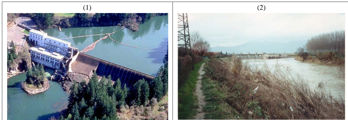
Figura A4.52 – Alterazione delle portate liquide. Tipiche opere di alterazione. (1) Diga; (2) scolmatore.
