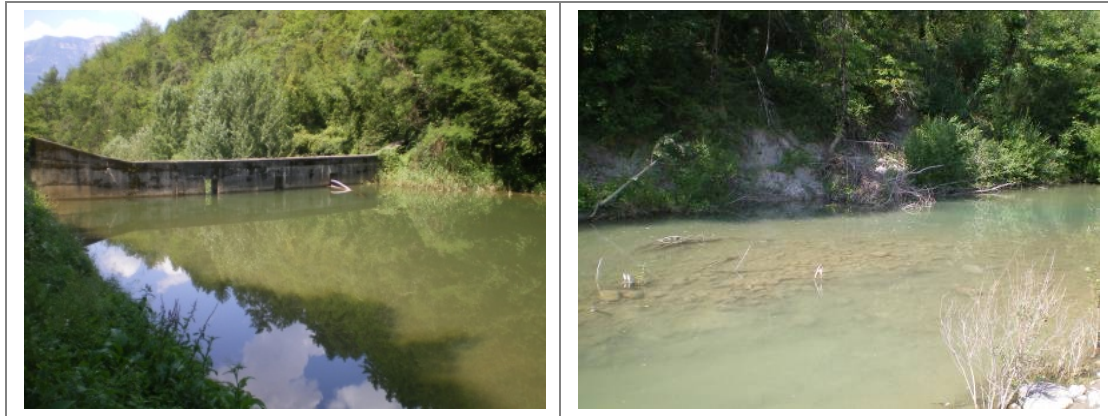
Figura 12.7 – Esempio di opera trasversale (a sinistra) che potrebbe determinare le condizioni di cui al caso 5 previsto in Tabella 12.1 . Il corpo idrico a monte di briglie di trattenuta non colmate o di traverse fluviali, o comunque contenente almeno una di queste strutture, viene considerato potenzialmente HMWB se l'estensione del tratto reso artificialmente lentico dalle opere stesse (a destra) è dominante rispetto alla lunghezza del corpo idrico (> 50%).
