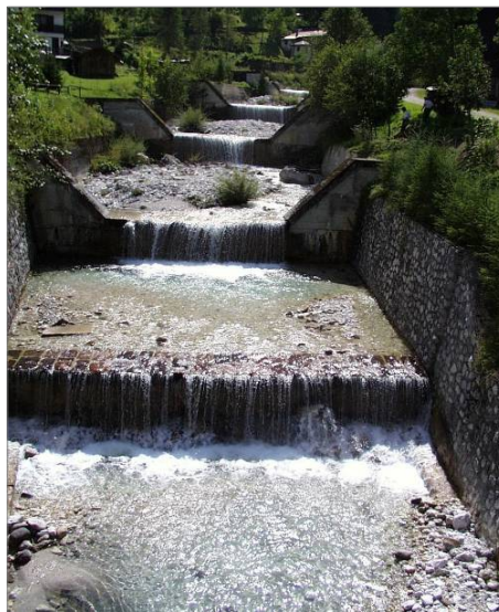
Figura 4.34 – Alveo a fondo artificiale sistemato con briglie ad interdistanza ridotta (T. Pramper, Belluno).
