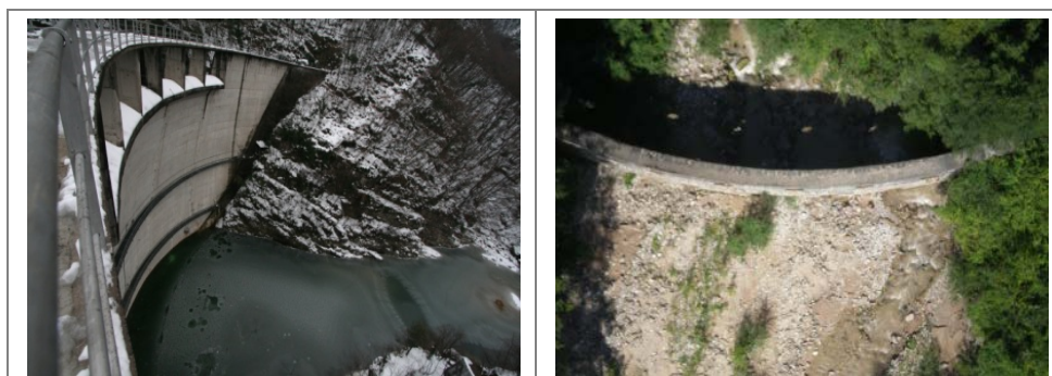
Figura 12.6 – Esempi di opere trasversali che possono determinare per i corpi idrici immediatamente a valle di esse le condizioni di cui al caso 4 previsto in Tabella 12.1 . A sinistra diga, a destra briglia di trattenuta non colmata.
