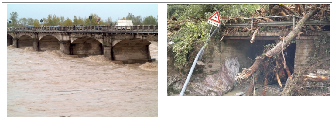
Figura A7.12 – Ponti del tipo 2: a sinistra, con pile in alveo, di sufficiente ampiezza per non causare ostruzioni nel caso di trasporto di legno non intenso (immagine tratta da http://tribunatreviso.gelocal.it ); a destra, a campata unica con l'impalcato di altezza teoricamente sufficiente ma con luce di ampiezza troppo ridotta con trasporto intenso di materiale legnoso (si ringrazia per foto la Provincia di La Spezia).
