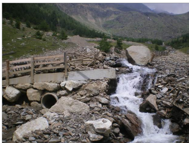
Figura A7.10 – Tombinatura occlusa da trasporto di sedimento (colata detritica) con conseguente avulsione.
