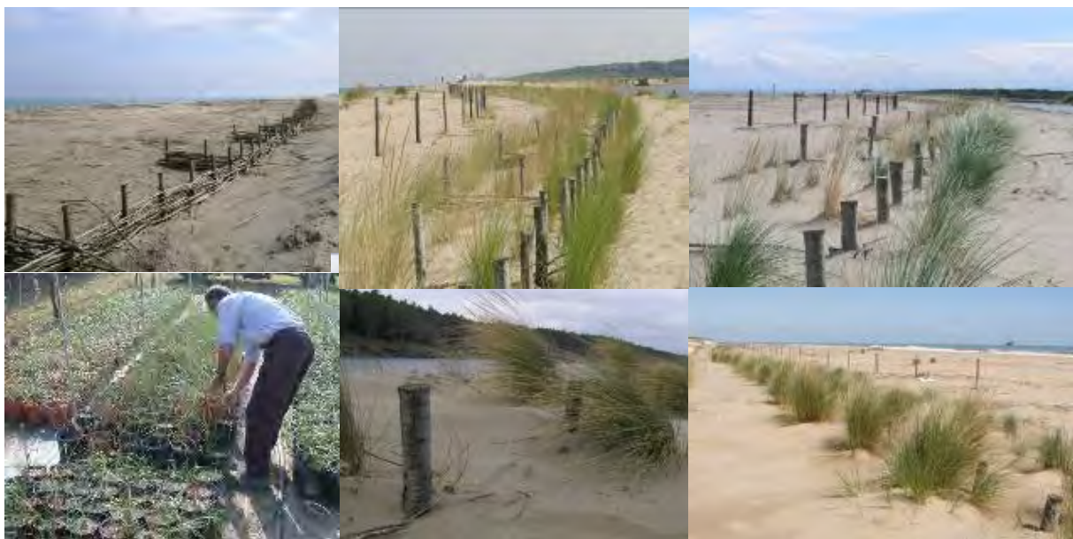
Figura 1.8.1 - Esempio degli effetti di un intervento di restauro e consolidamento dunale mediante la vegetazione (POSIDUNE, 2007).
