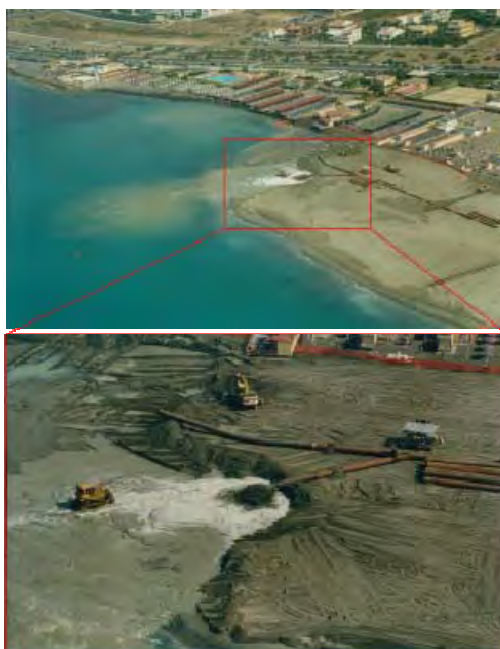
Figura 1.5.1 - Operazioni di ripascimento (Foto Regione Lazio).
