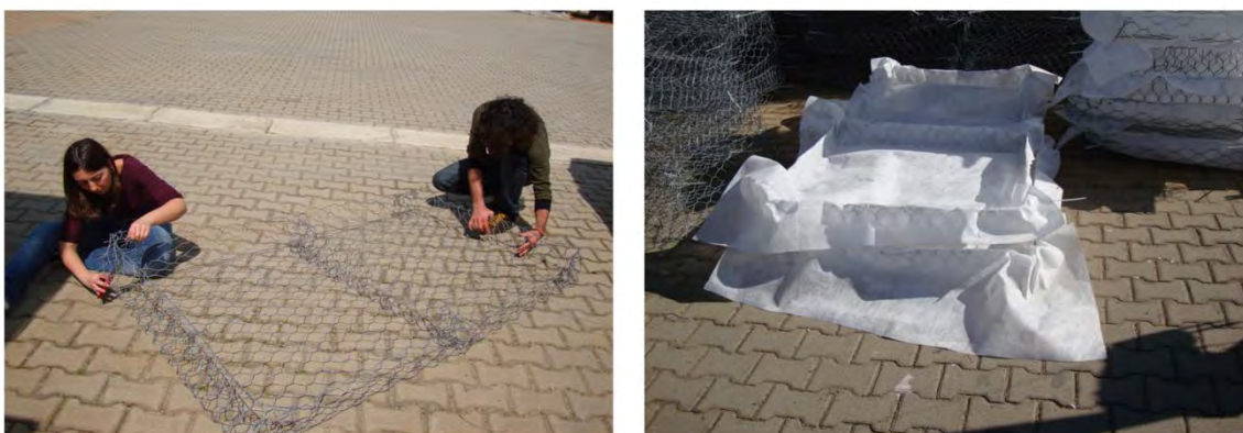
Figura 2 – Fasi di confezionamento dei materassi.
