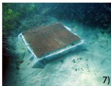
Figure 6-8 - Materasso collocato sul fondo e riempito di sabbia (6), materasso coperto con geostuoia (7), materasso con geostuoia fissato lungo il bordo con fascette di nylon (8).
