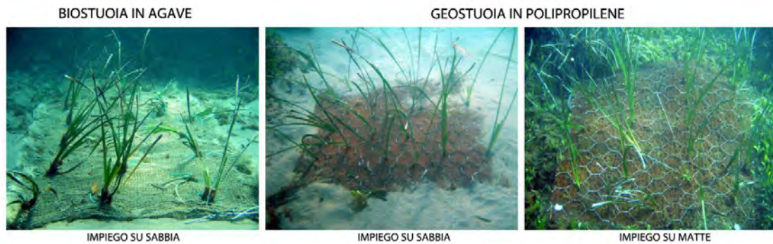
Figura 13 - Sistemi fissati sul fondo sabbioso e su matte per mezzo di picchetti d'acciaio.
