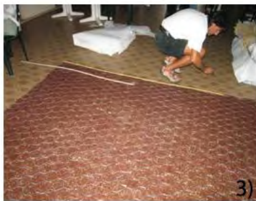
Figure 3-5 - Rivestimento del materasso rivegetabile in rete metallica con geotessuto (3), geostuoia in fase di sezionamento (4), materasso rivegetabile pronto per la messa in mare (5).
