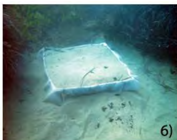
Figure 6-8 - Materasso collocato sul fondo e riempito di sabbia (6), materasso coperto con geostuoia (7), materasso con geostuoia fissato lungo il bordo con fascette di nylon (8).
