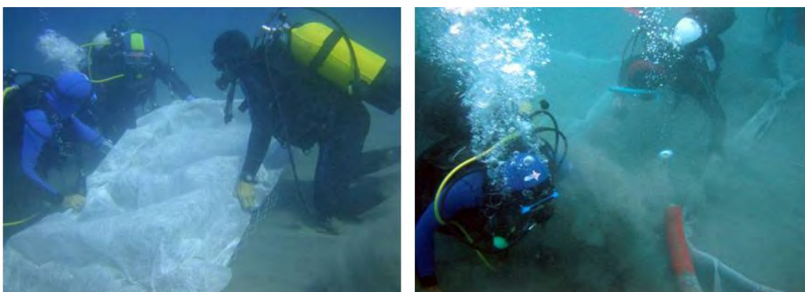
Figura 3 - Posizionamento subacqueo dei materassi rivestiti di tessuto Terram 1000 (a sinistra) e riempimento dei materassi con sorbona ad aria (a destra).
