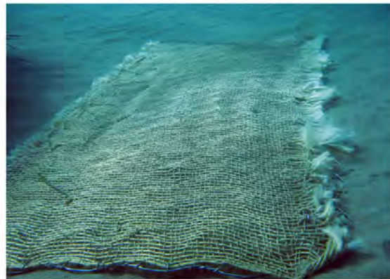
Figura 2 - Materasso in rete metallica con geostuoia in polipropilene e geotessuto in bopolimero (sulla sinistra) e biostuoia in agave (sulla destra).
