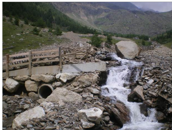
Figura A7.10 – Tombinatura occlusa da trasporto di sedimenti (colata detritica) con conseguente avulsione.
