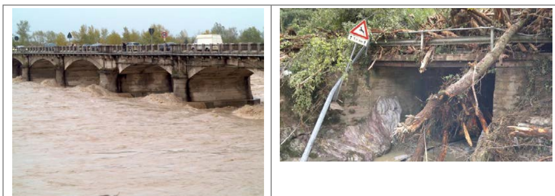
Figura A7.12 – Ponti del tipo 2: a sinistra, con pile in alveo, di sufficiente ampiezza per non causare ostruzioni nel caso di trasporto di legno non intenso (immagine tratta da http://tribunatreviso.gelocal.it ); a destra, a campata unica con impalcato di altezza teoricamente sufficiente ma con luce di ampiezza troppo ridotta con trasporto intenso di materiale legnoso (si ringrazia per foto la Provincia di La Spezia).
