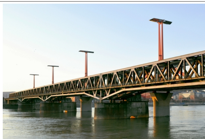
Ponte in acciaio
