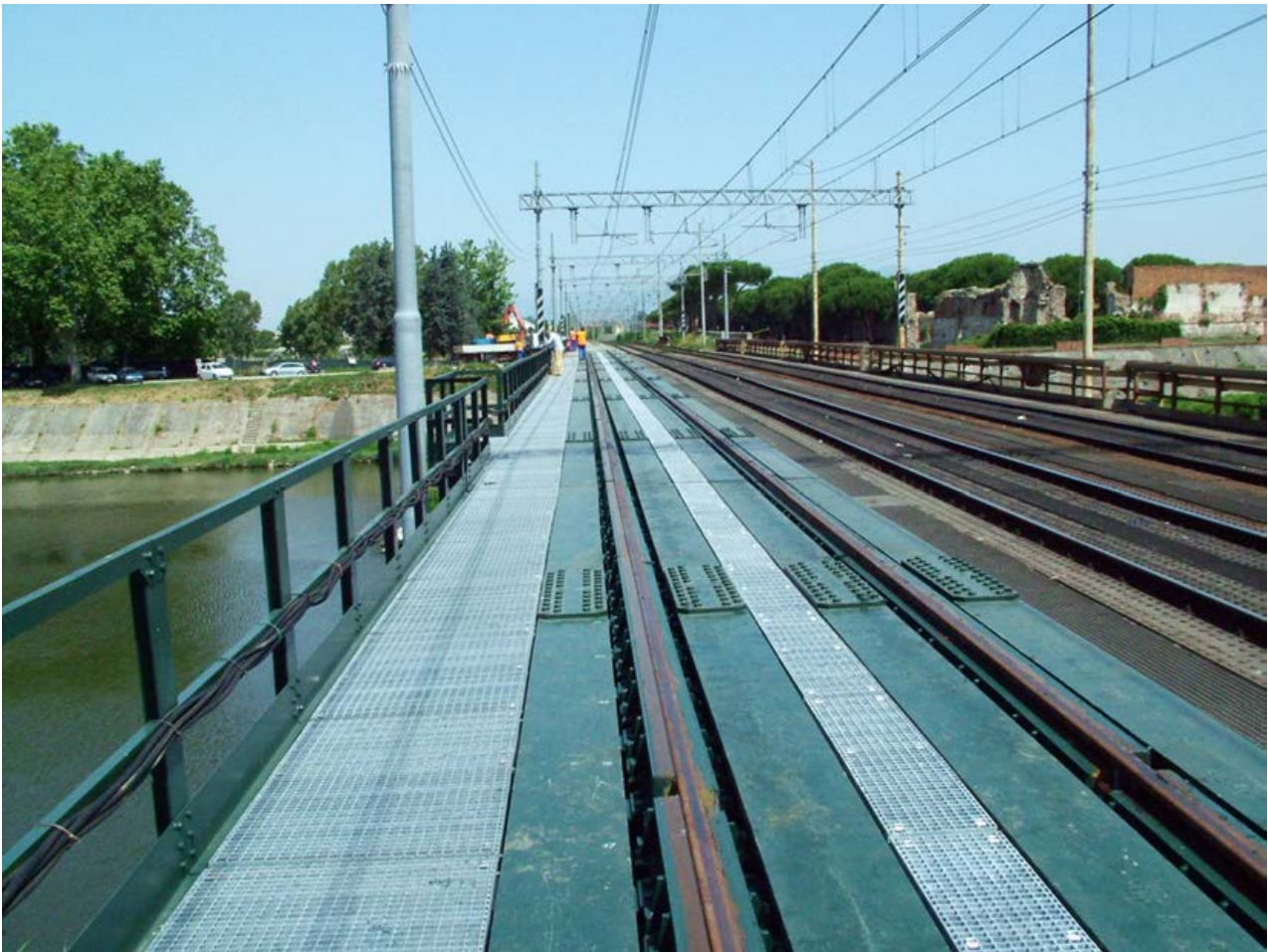
"Embedded rail" sul ponte di Pisa.
