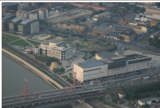
Vista d'insieme ponte in acciaio (Millennium City Center)
