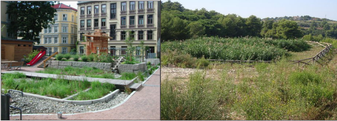
Figura 12 – A sinistra: esempio di sistema di fitodepurazione progettato come parco urbano (Oslo), a destra: impianto di fitodepurazione realizzato per affinamento delle acque e per la riqualificazione ambientale, Cave di S. Carlo di Solvay Italia SpA, Comune San Vincenzo (LI)
