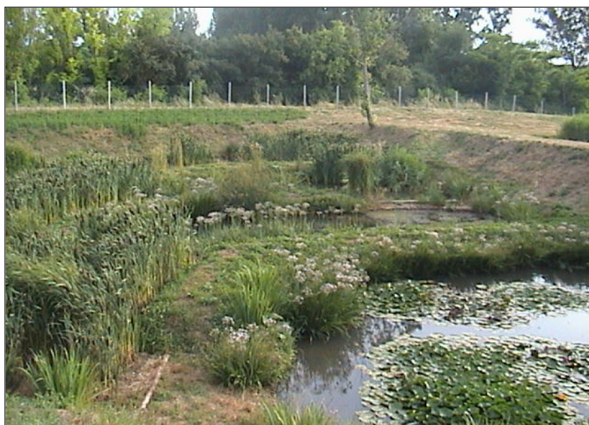
Figura 9 – Sistema di fitodepurazione per il trattamento del percolato della discarica di Taglietto, Comune Villadose (RO)
