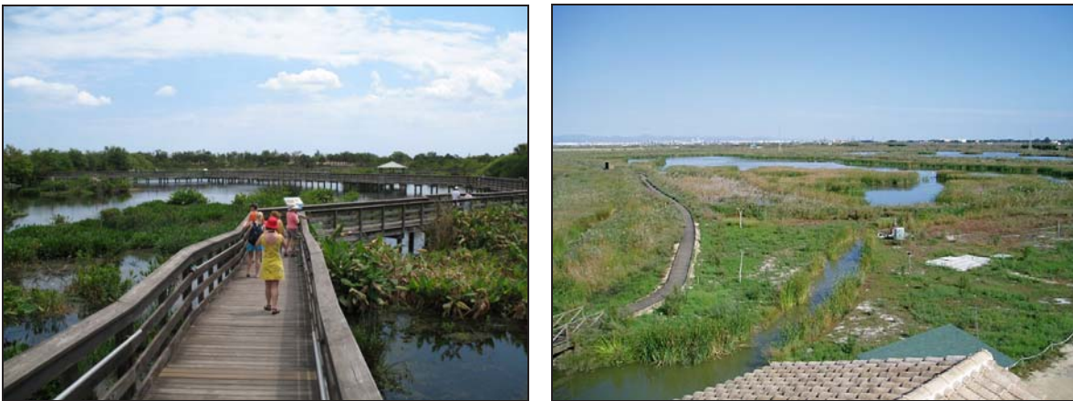
Figura 13 – Sistemi di affinamento: a sinistra impianto Wakodahatchee Wetlands (Florida) a valle del sistema tecnologico “Southern Region Water Reclamation Facility”. A destra impianto El Tancat de la Pipa (Spagna), a valle del sistema tecnologico di Albufera
