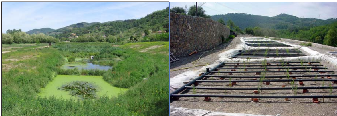
Figura 5 – Sistemi di fitodepurazione: a sinistra panoramica impianto a servizio del Comune di Dicomano (3.500 AE), a destra impianto a servizio della Frazione di Olle (200 AE) Comune di Finale Ligure
