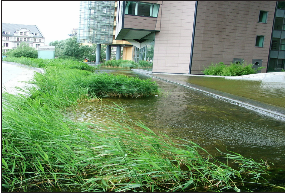
Figura 10 – Sistema a flusso libero per il trattamento delle acque meteoriche e loro riutilizzo, Postdamer strasse Berlino
