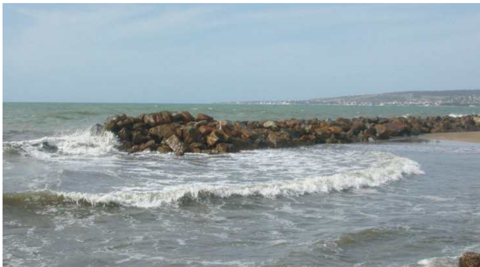
Figura 4.1.14: Barriera frangiflutti in massi di cava. Il suo scopo principale è quello di intercettare le onde, dissipandone l'energia prima che colpiscano la costa. Nella zona di calma presente sul lato terra, se il rapporto tra larghezza del varco e distanza dalla battigia è stato ben calcolato, si ha tendenza alla deposizione di sedimento marino.
