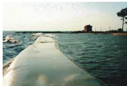
Figura 4.1.22: Barriere con tubi Longard. Un tubo Longard è una struttura con un doppio strato in geotessuto, costituito da polietilene impermeabile, con un diametro di 1-1,8 metri ed una lunghezza di 100 metri. Per il riempimento dell'involucro vengono realizzati due fori di 50 cm di diametro muniti di flangia. Il tubo viene esteso per la sua intera lunghezza e riempito idraulicamente con sabbia prelevata in sito, dopodiché i fori vengono sigillati.
