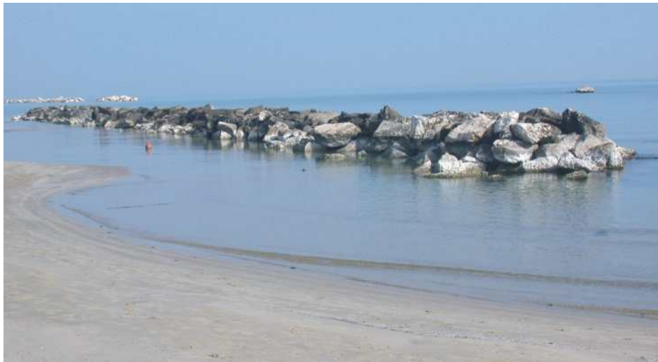
Figura 4.1.15: Barriera in massi naturali. Normalmente viene costruita su un adeguato imbasamento e con un nucleo in pietrisco. I materiali naturali più utilizzati sono in genere quelli calcarei (ad es. brecce calcaree cementate), ma si fa spesso ricorso anche a materiali ignei, quali graniti, lave, ecc.
