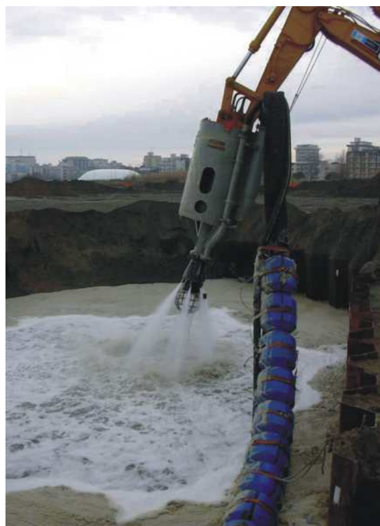
Figura 4.4.9: Disagregatore ad acqua utilizzato per mobilizzare il sedimento dall'area di dragaggio (Foto A. Peretti).
