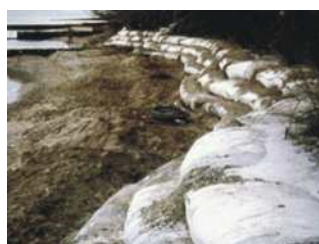
Figura 4.3.25: Rivestimento con Unità Texicon.
