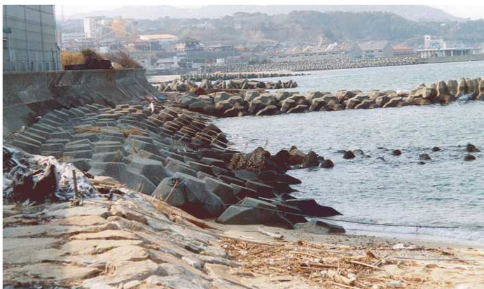
Figura 4.3.1: Sistema combinato di strutture aderenti a difesa di un impianto industriale. La scogliera è rivestita con elementi in cemento armato atti a creare una superficie frastagliata per favorire la dissipazione dell'energia del moto ondoso incidente prima dell'urto finale con il muro. Si noti la curvatura del muro verso mare con funzione antisormonto.
