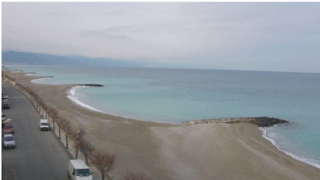
Figura 4.2.1: Capo d'Orlando (ME) Campo di pennelli. Una spiaggia protetta con tale sistema viene modellata dalla interazione tra le singole strutture e le correnti litoranee, assumendo, col passare del tempo, una caratteristica conformazione dentellata.
