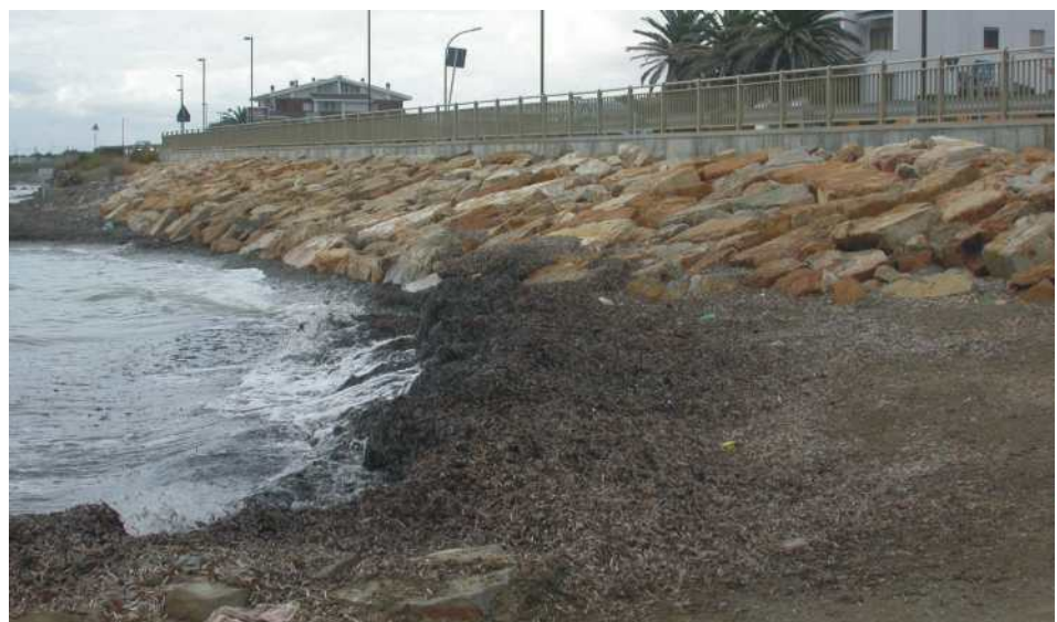
Figura 4.3.10: Rivestimento in massi. Spesso per limitare i danni alle infrastrutture viarie e ferroviarie causati da tempeste e mareggiate, si utilizzano rivestimenti con materiali di cava. La loro costruzione a ridosso delle massicciate viene eseguita con una disposizione più o meno regolare dei massi che ne aumenta la stabilità, mentre la loro conformazione superficiale irregolare consente una buona dissipazione dell'energia delle onde incidenti.
