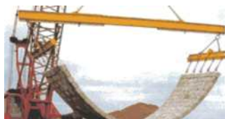
Figura 4.3.27: Operazione di installazione di una Unità Dytap
