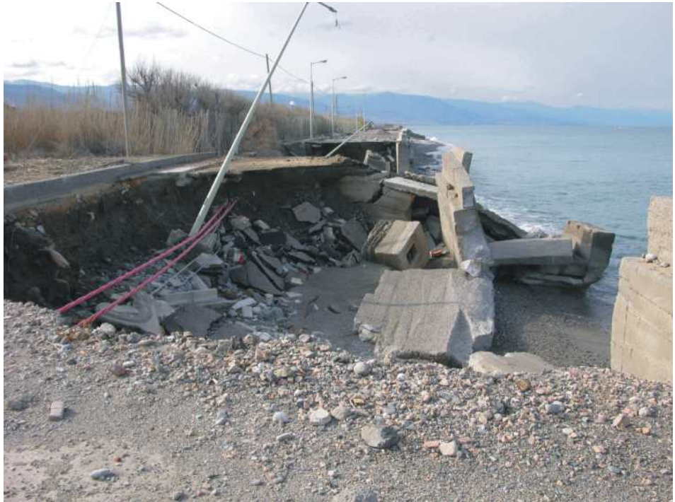
Figura 4.0.3: Conseguenze dell'attacco ondosu su una strada litoranea. L'azione erosiva delle onde incidenti si esplica mediante violenti impatti che possono anche demolire la struttura. Nella maggior parte dei casi si deve prevedere un adeguamento o una protezione al piede dell'intervento.
