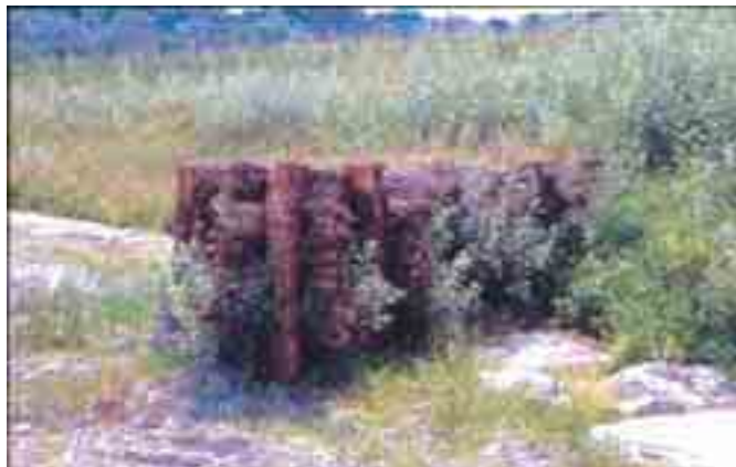
Figura 6.2.10: L'immagine ritrae un repellente vivo, realizzato con pali di legno e fascine vive di salice. Nel giro di un anno i salici hanno ricacciato e la struttura viene consolidata ed inserita ambientalmente. Il materiale di riempimento non deve essere di dimensioni troppo piccole per impedire che possa venire asportato dalla corrente. D'altro canto il riempimento non dovrà essere troppo grossolano per consentire lo sviluppo delle piante. In certi casi un compromesso tra le due esigenze si può ottenere differenziando granulometricamente il materiale più esterno da quello del nucleo.
