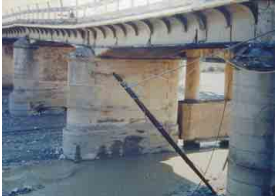
Figura 6.0.2: Cedimento del terreno dovuto all'erosione intorno ai pozzi di fondazione della pila di ponte.
