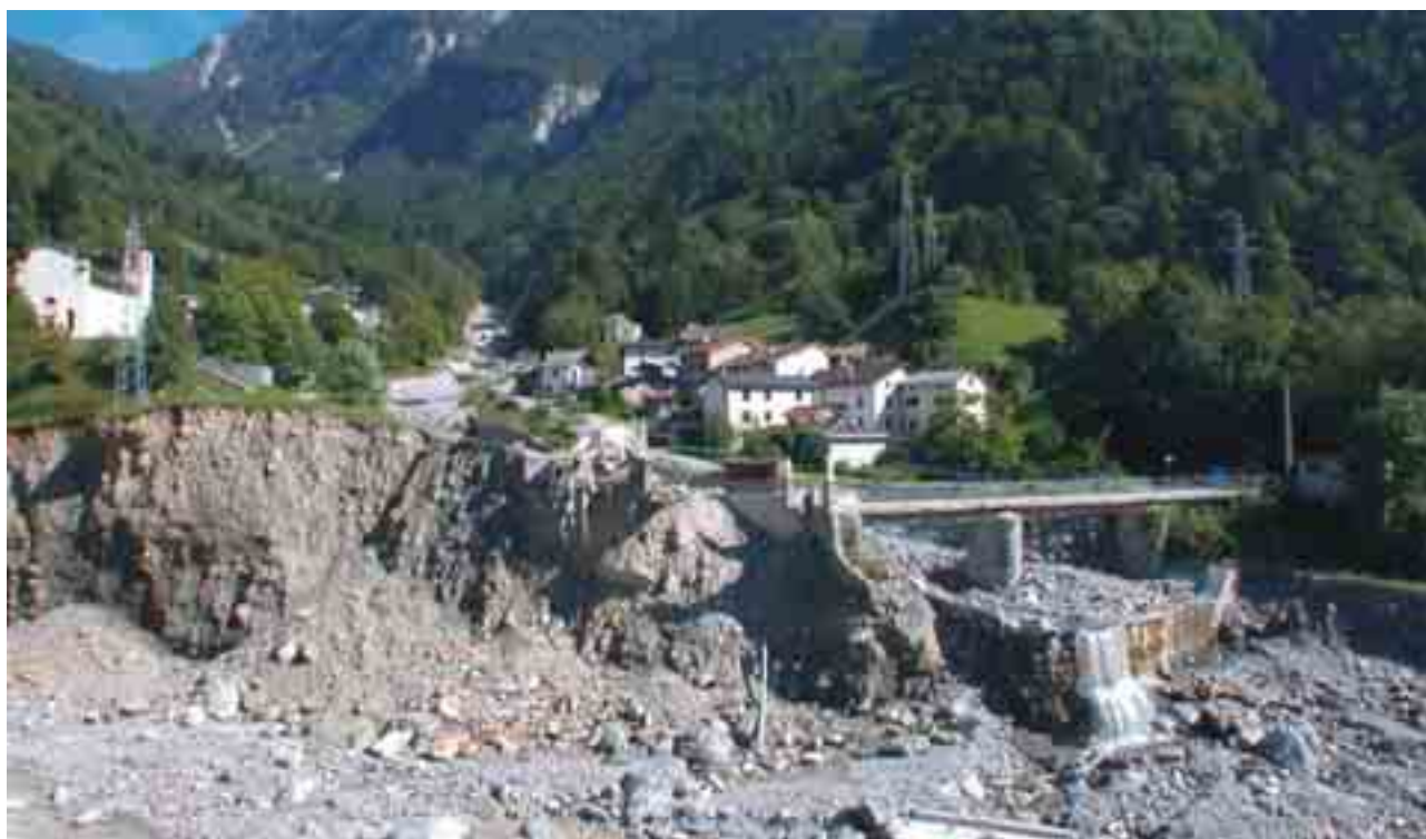
Figura 1.3.3: Friuli (alluvione agosto 2003). Veduta della frazione di Pietratagliata in Comune di Pontebba. Disastrose conseguenze dovute alla violenta erosione del fondo e della sponda in sinistra idrografica del fiume Fella.
