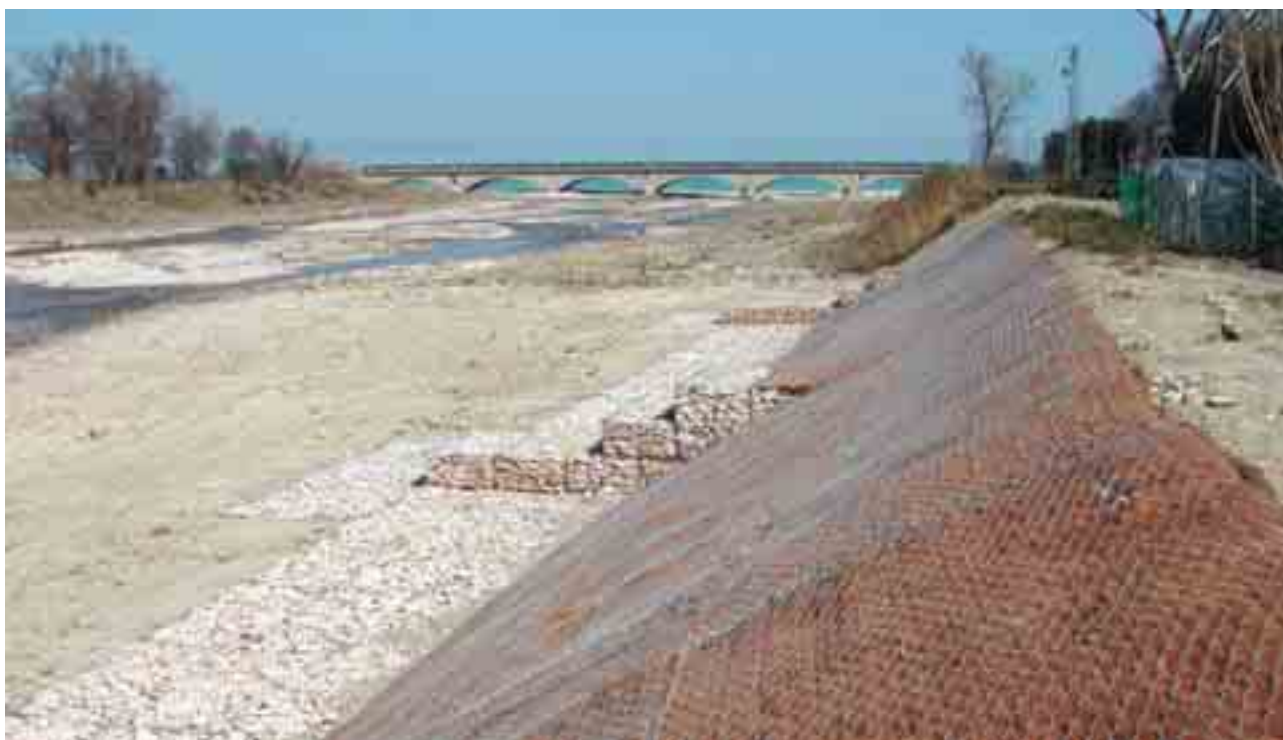
Figura 1.5.1: Serie di interventi strutturali di sistemazione. Riprofilatura dell'alveo, rivestimento delle sponde con biostuie e rete metallica a doppia torsione, pennelli e presidi al piede in gabbioni. (Fiume Aso, Comuni di Pedaso e Altidona)
