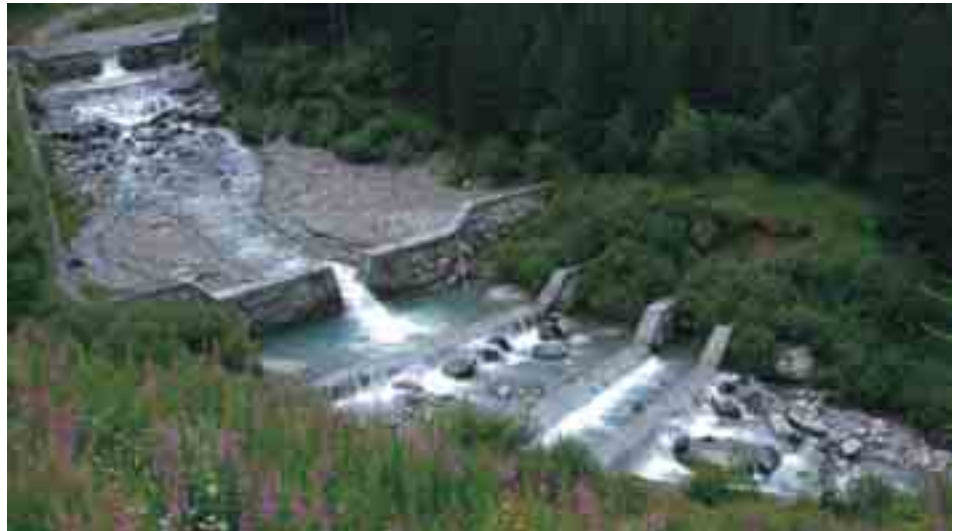
Figura 1.8.1: Stabilizzazione di un'asta torrentizia mediante una serie di piccole briglie e bacini di dissipazione in ambiente alpino (Valtellina, SO).
