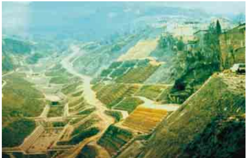
Figura 1.8.2: Consolidamento di un versante sottostante all'abitato di S. Mango sul Calore (Avellino). L'intervento ha comportato la stabilizzazione dell'asta torrentizia al piede della pendice, mediante salti di fondo e rivestimenti in gabbioni, mentre per garantire la stabilità del versante, si è fatto uso di terre rinforzate in 'Terramesh' in alternanza con opere di sola protezione superficiale tramite graticciate.
