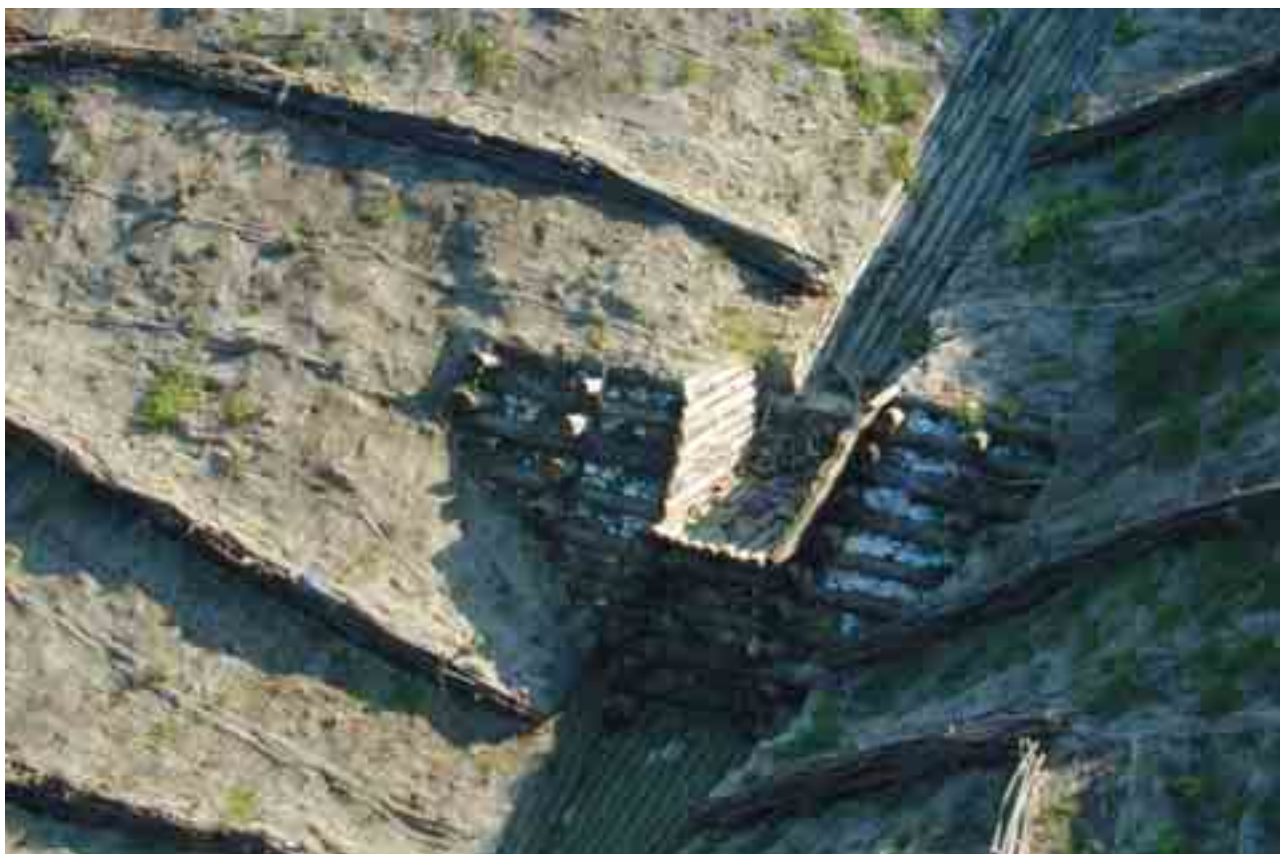
Figura 1.7.1: Complesso intervento di sistemazione e consolidamento dei versanti di un torrente montano in forte erosione. L'intervento ha previsto il ricorso a varie tecniche d'ingegneria naturalistica: rimodellamento del pendio, realizzazione di viminate, rivestimento del fondo dell'impluvio con tondame e costruzione di briglie in legname e pietrame, rivestimento con teli di biotessili ed inerbimenti.
