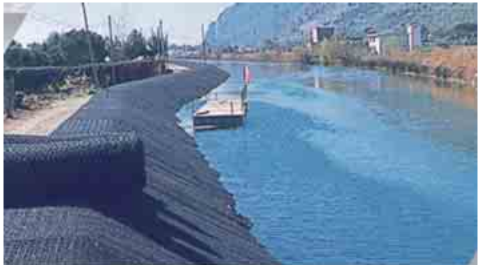
Figura 1.8.12: Fase di posa di geostuoia tridimensionale rinverdibile a difesa di una sponda.
