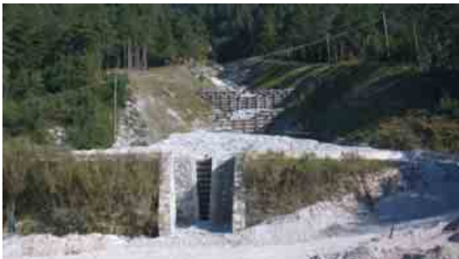
Figura 1.8.6: Sistema di briglie in legno e di briglia a fessura con piazza di deposito retrostante; Le sponde sono state protette con un rivestimento di biostuoie e rete metallica a doppia torsione. Si può osservare la piazza di deposito completamente riempita di materiale alluvionale, (alluvione Friuli del 29 agosto 2003, Ugovizza).
