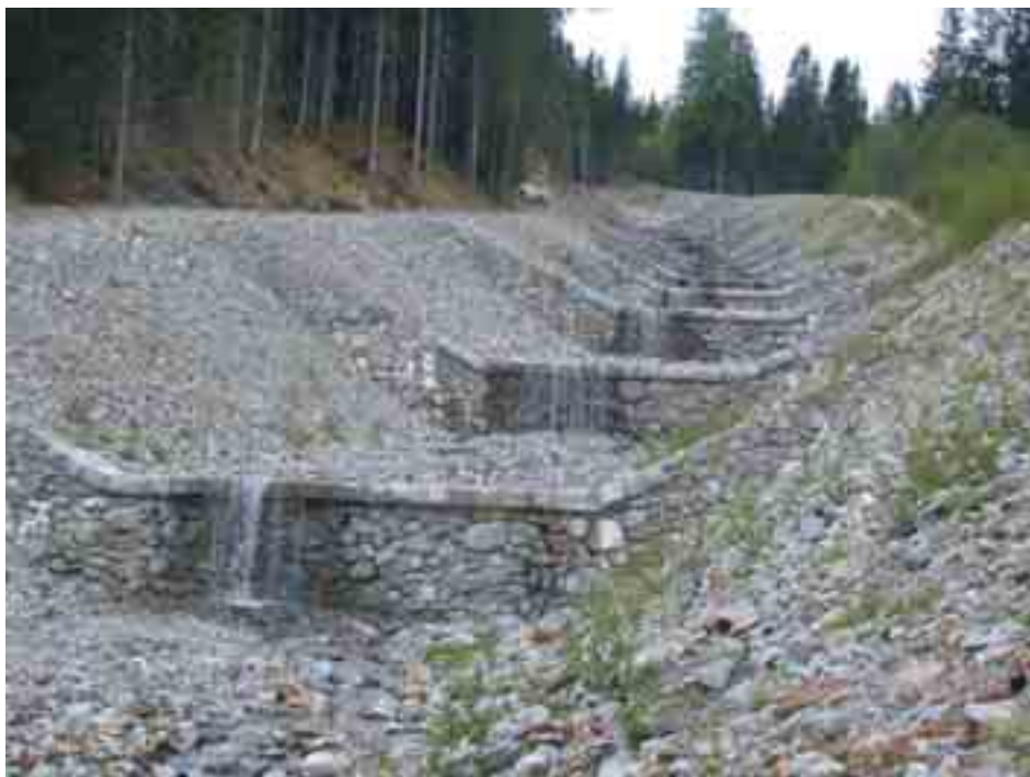
Figura 1.8.9: Gradinata di briglie in c.a. rivestite in pietra.
