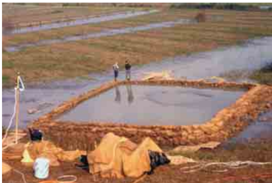
Figura 2.1.6: Fontanazzo formatosi a causa del sifonamento lungo gli argini del fiume Oglio in comune di Marcaria (alluvione ottobre 2000).
