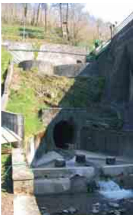
Figura 3.1.3: Serbatoio di piena di Vinchiana (LU). A sinistra, vista dell'uscita della galleria di deviazione del torrente per le normali portate, in alto lo sfioratore di troppo pieno dell'invaso. A destra vista dell'invaso da monte.
