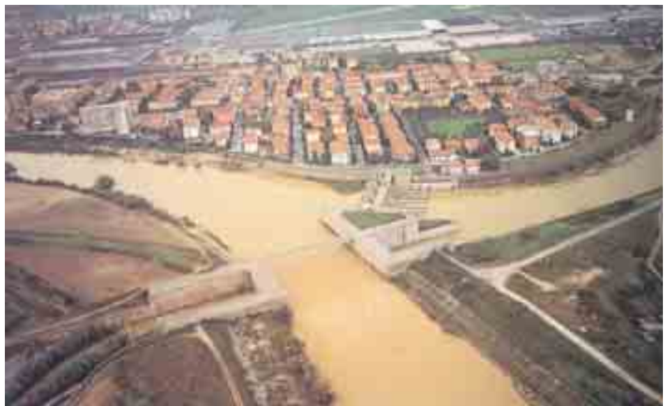
Figura 3.4.2: Opera di presa dello scolmatore sull'Arno a Pontedera, due giorni dopo l'evento alluvionale dell'8 Ottobre 1993.
