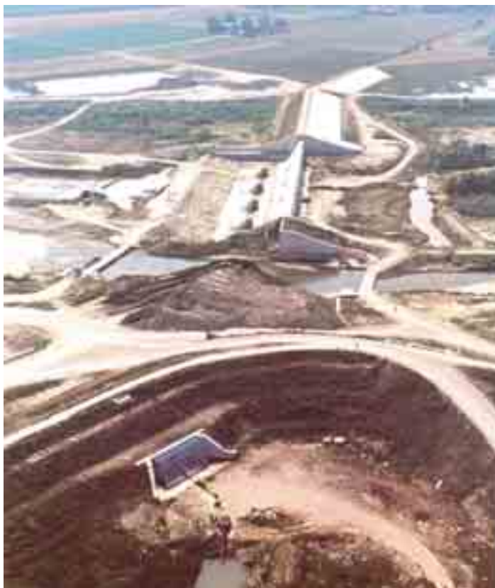
Figura 3.0.1: Costruzione di una cassa di espansione sul fiume Secchia. Si può vedere lo sbarramento ed in primo piano l'arginatura della cassa di espansione con l'imbocco dello scaricatore. Si tratta di opere complesse e di grandi dimensioni che determinano un impatto significativo sul territorio
