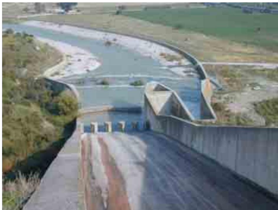
Figura 3.1.6: Vista da monte dello scaricatore di superficie e di fondo della diga del Liscione sul fiume Biferno (Guardialfiera, CB). Si osservino i dispositivi per la dissipazione dell'energia della corrente al fondo dello scivolo.
