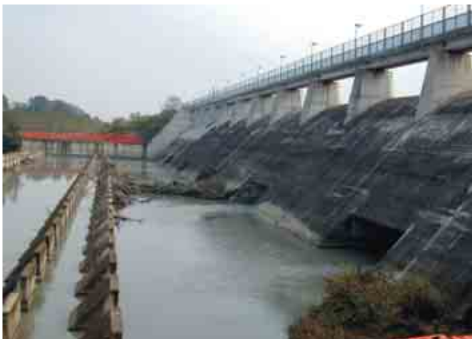
Figura 3.2.2: Cassa di espansione in linea sul fiume Secchia, vista da valle dello sfioratore di piena e delle aperture per il regolare deflusso.
