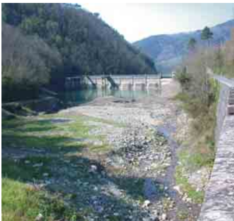
Figura 3.1.3: Serbatoio di piena di Vinchiana (LU). A sinistra, vista dell'uscita della galleria di deviazione del torrente per le normali portate, in alto lo sfioratore di troppo pieno dell'invaso. A destra vista dell'invaso da monte.
