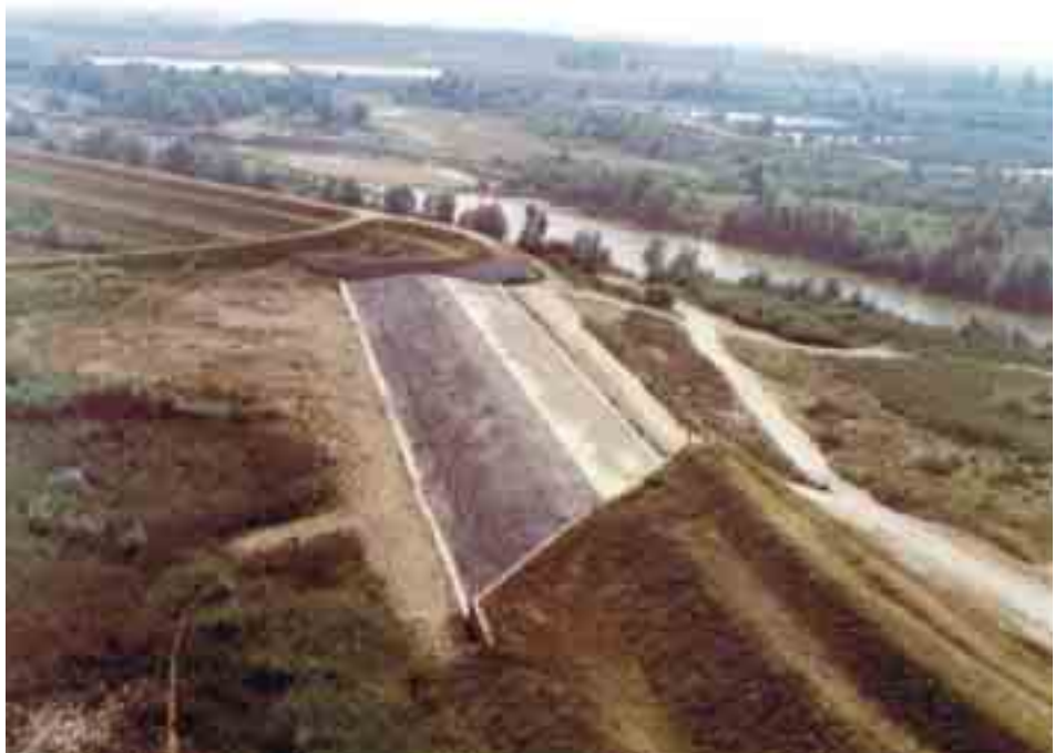
Figura 3.2.10: Sfiatore sull'argine sinistro del Secchia. Quando il livello del fiume raggiunge la soglia, una parte della portata si scarica nella cassa di espansione sulla sinistra della foto.
