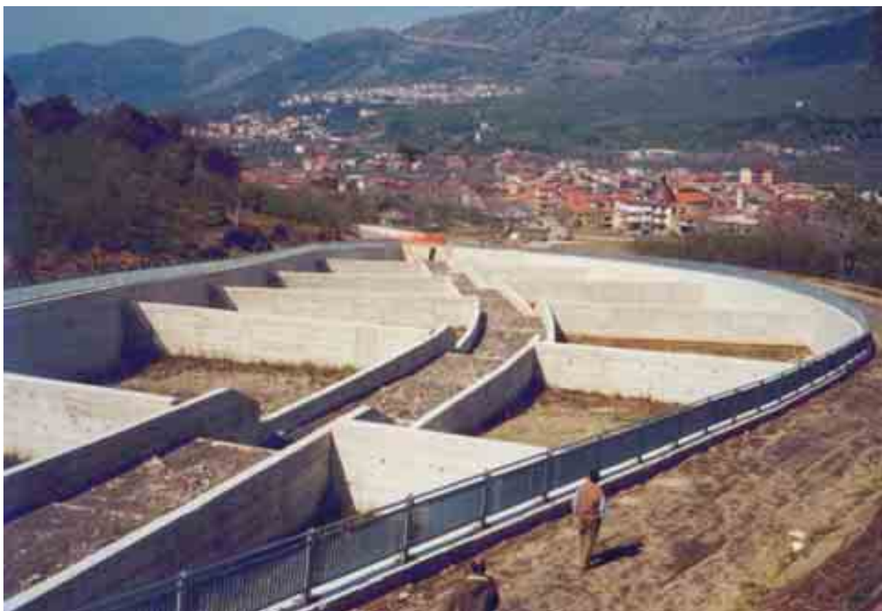
Figura 7.1.11: Casse di ritenuta in cemento armato poste ai lati del canale di convogliamento delle colate. La gradonatura del fondo del canale rallenta le colate e favorisce il riversamento nelle casse di ritenuta. (Quindici AV)
