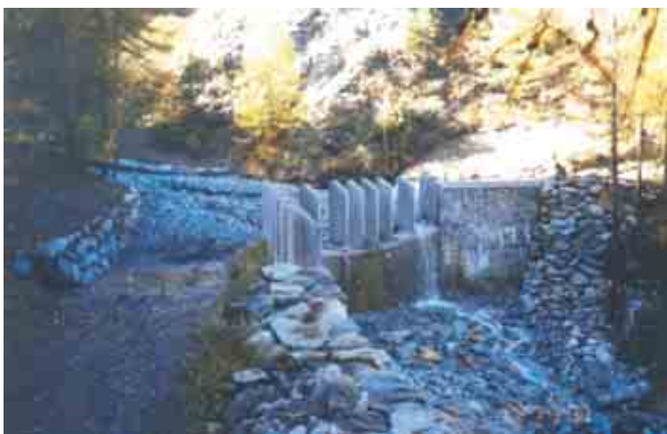
Figura 7.1.3: Struttura di intercettazione costituita da soli rostri in cemento armato verticali. La particolarità di questa struttura è dovuta alla presenza di due ordini perpendicolari di elementi in cemento armato, in grado di offrire protezione su due lati
