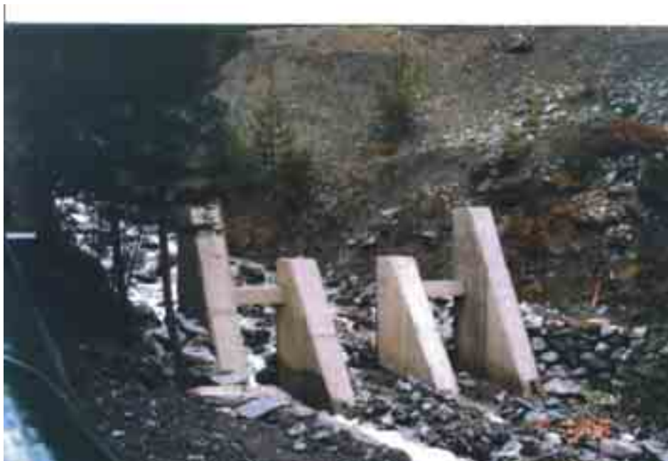
Figura 7.1.4: Struttura aperta costituita da soli contrafforti per il contenimento di materiali di grandi dimensioni. La distanza fra i contrafforti è di 2.5 m in grado di ammettere il passaggio di mezzi meccanici per lo sgombero dei materiali accatastati a monte. I contrafforti maggiori sono alti 7 m e, dal punto di vista statico, sono vincolati con un tirante attraversante la base ai fini dell'equilibrio al ribaltamento e la fondazione è ancorata con micropali ai fini della resistenza allo scorrimento (Torrente Piccola Dora in Comune di Cesana, vista da valle).
