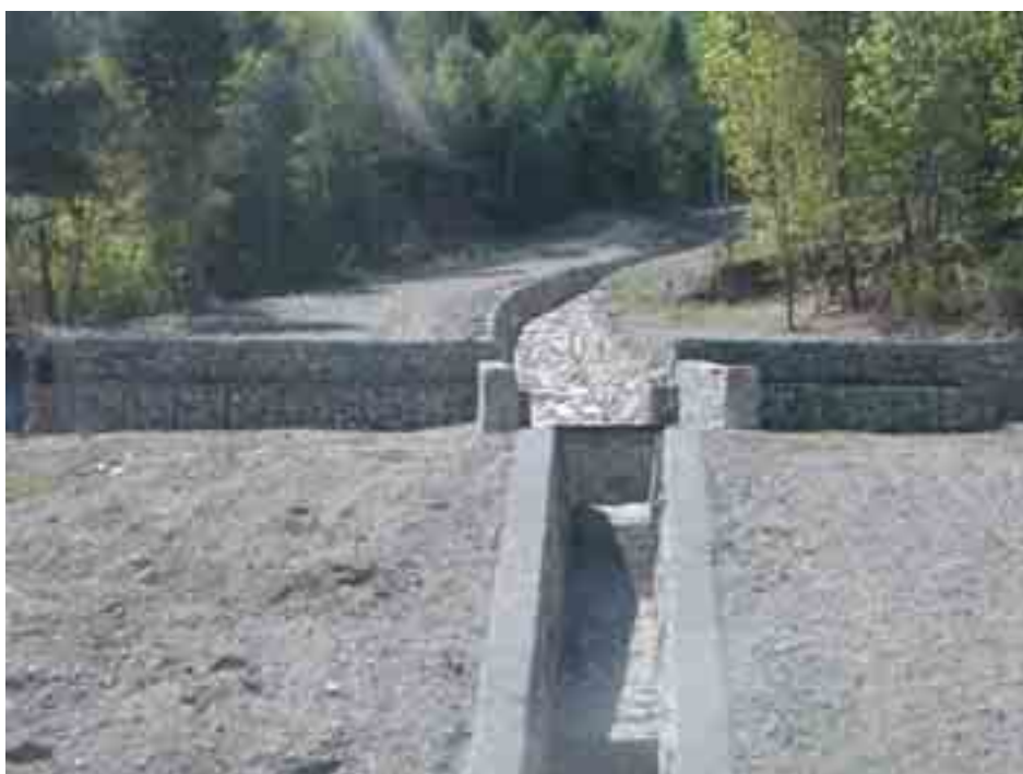
Figura 7.2.3: In certi casi a monte della struttura di deviazione si può creare una bassa struttura di intercettazione in grado di captare parte del volume della colata, nella foto se ne vede un esempio realizzato con gabbioni in rete metallica a doppia torsione, con al cento il canale rivestito in pietrame che convoglia le portate liquide.
