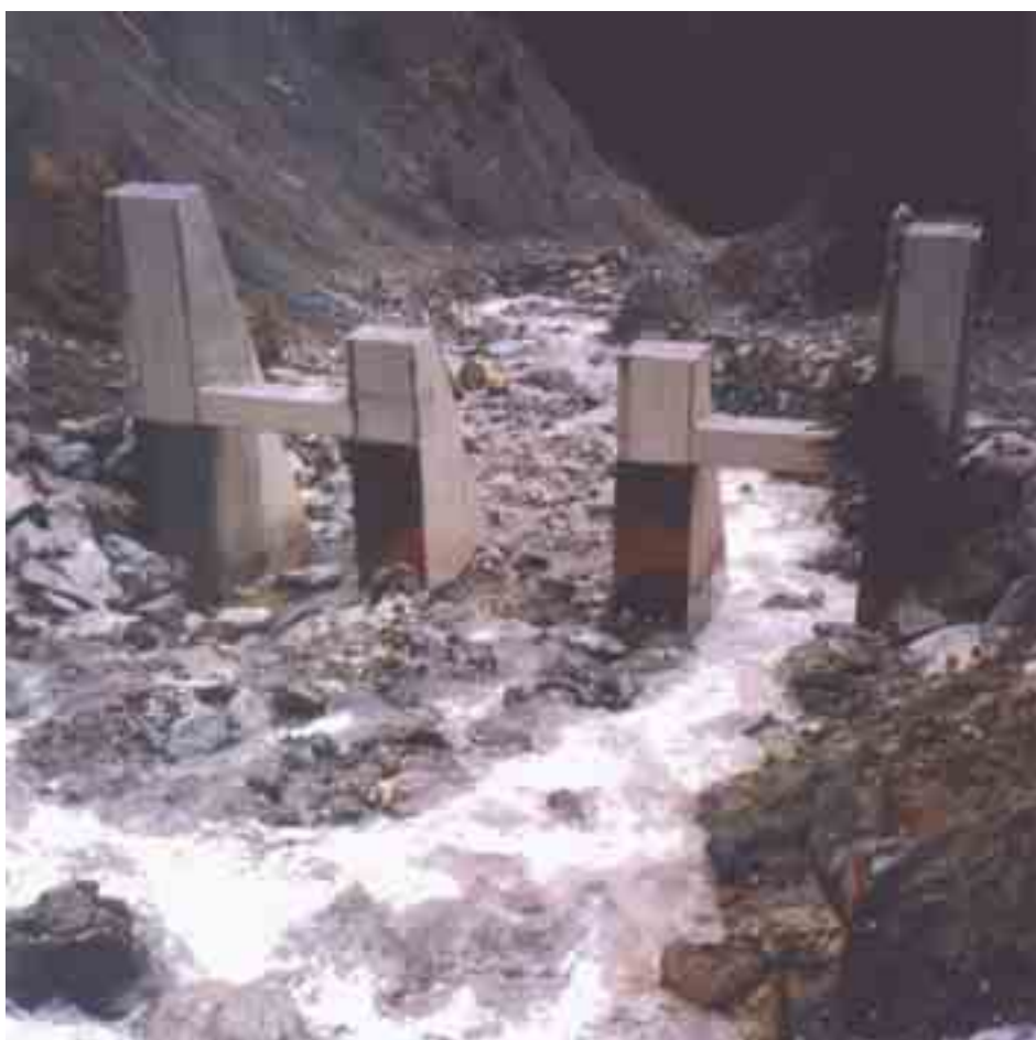
Figura 7.1.5: La stessa struttura precedente vista da monte. Si osservi il rivestimento in lamiera di acciaio speciale (acciaio T4) per la protezione contro i danni del trasporto solido.
