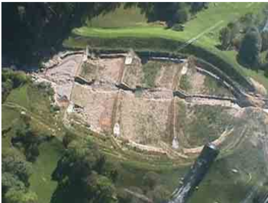
Figura 7.1.10: Piazza di deposito con setti in terra compattata, dotati di una fessura centrale per consentire il passaggio delle acque in condizioni normali. (Vallescura BG).
