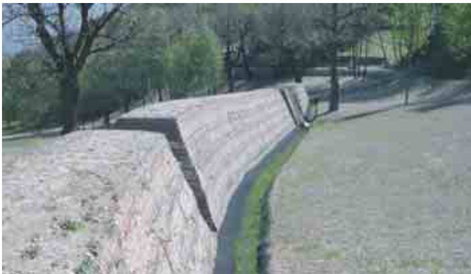
Figura 7.1.8: Il rilevato di intercettazione precedente visto da monte; le foto sono state riprese prima del rinverdimento e si può notare il canale per la raccolta delle acque superficiali che corre lungo l'opera, rivestito con una geostuoia tridimensionale, armata con rete metallica a doppia torsione, rinverdata.
