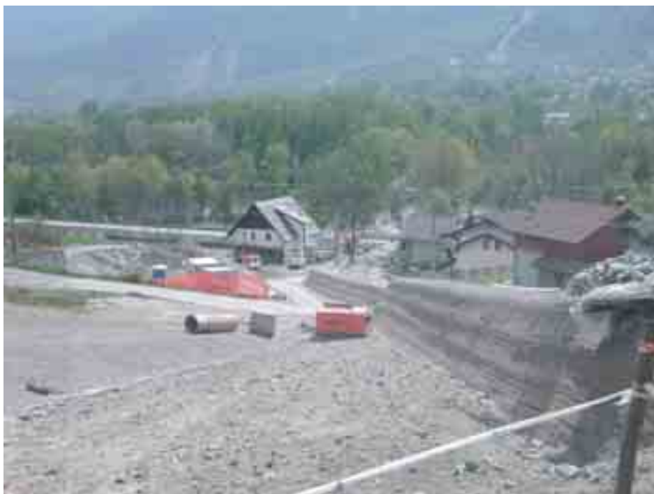
Figura 7.2.2: Nella foto è mostrato un rilevato di diversione in fase di costruzione (Messigny (AO), a monte di un gruppo di case. Si tratta di strutture realizzate in terra rinforzata con elementi in rete metallica a doppia torsione plasticata, con una protezione antierosiva di paramento in biostuoia di fibre di cocco.
