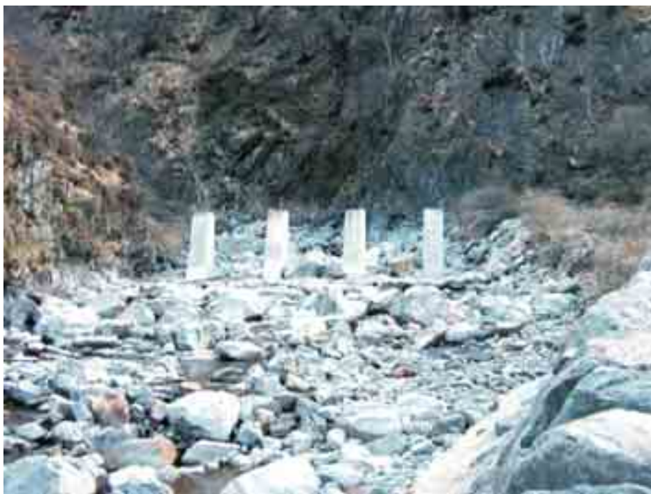
Figura 7.1.1: Una struttura di intercettazione aperta posta lungo un torrente. L'opera è molto massiccia per poter resistere alle forze elevate esercitate dalle colate ed all'impatto dei singoli blocchi. La struttura è molto aperta per opporsi solamente alle colate detritiche lasciando libero il flusso delle acque anche in condizioni di piena.
