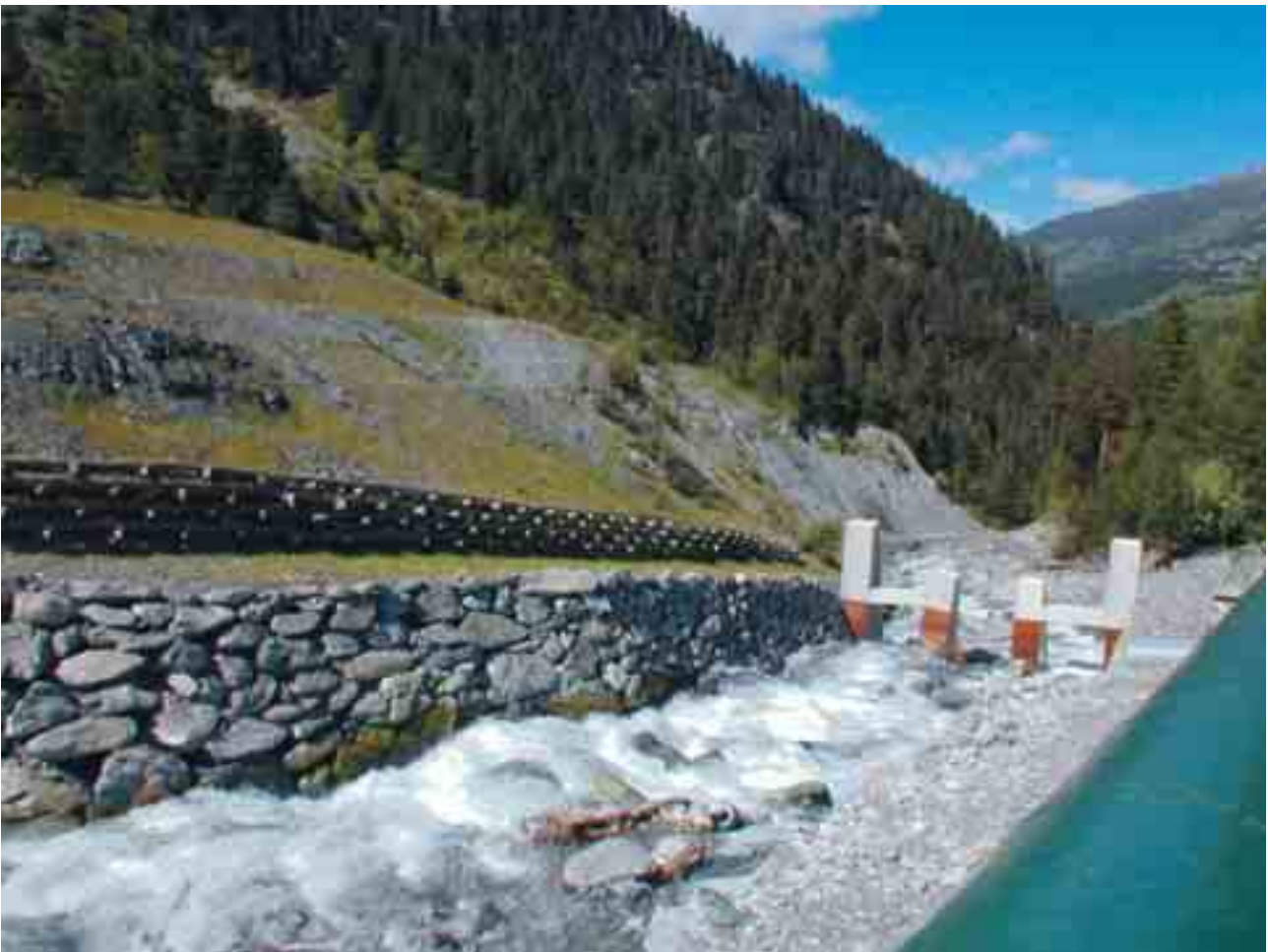
Figura 7.0.6: La foto mostra l'associazione di sistemi di difesa dalle colate detritiche di tipo passivo ed attivo. Il muro di sponda e la palificata a parete doppia, hanno la funzione di proteggere dall'erosione e stabilizzare il versante, limitando l'apporto di materiale solido. La struttura di intercettazione aperta impedisce la propagazione delle colate.
