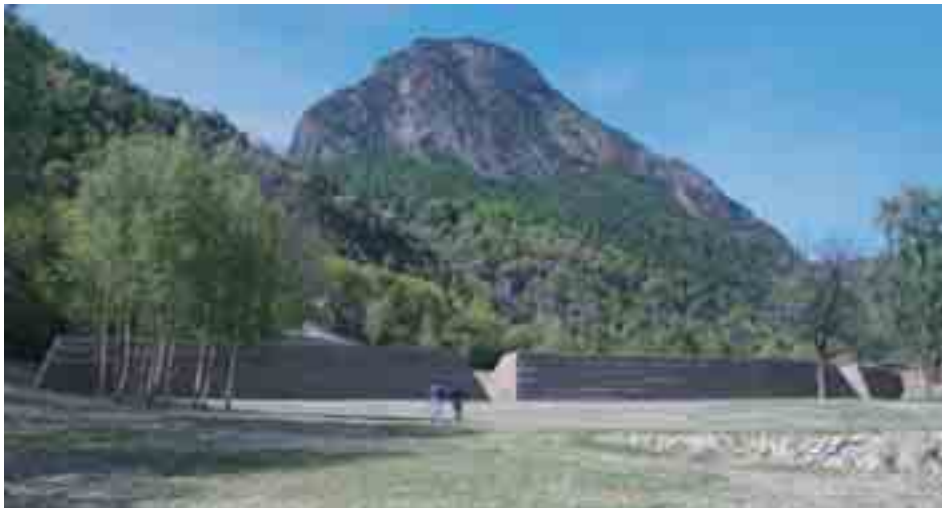
Figura 7.1.7: La figura mostra una struttura di questo tipo realizzata in Valle d'Aosta, vista da valle, si possono notare delle strette aperture che consentono il transito di mezzi d'opera. Quest'opera è stata realizzata in seguito all'evento alluvionale del 2000, utilizzando elementi di rinforzo in rete metallica a doppia torsione plasticati
