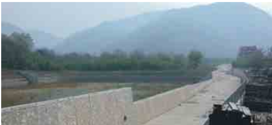
Figura 7.1.9: Una struttura di intercettazione chiusa posta a lato del percorso delle colate, il fango si riversa nella struttura attraverso uno sfioratore. Le sponde della vasca sono protette con muri in gabbioni di rete metallica a doppia torsione a maglie esagonali. (Quindici AV).
