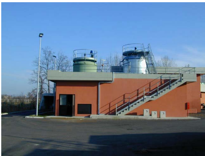
Figura 5.21 - Vista di insieme dell'area AF – Reattore coibentato fermentatore (50 m 3 ) - reattore verde deposito della FORSU selezionata e tritata (30 m 3 )
