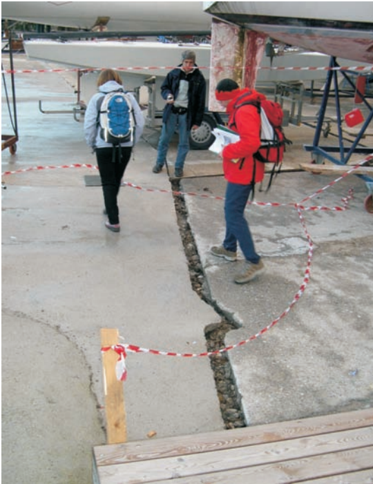
November 24, 2004, Salò, Italy, earthquake ( M_l=5.2 ) Salò: in the harbor evidence of liquefaction and localized (over an area of ca. 500 \text{ m}^2 ) lateral spreading was observed, with fissuring up to 30 cm wide parallel to the waterfront area. - Salò: nel porto sono state osservate evidenze di liquefazione ed espansioni laterali localizzati in un'area di circa 500 \text{ m}^2 , con fessure ampie fino a 30 cm parallele al fronte del porto.
