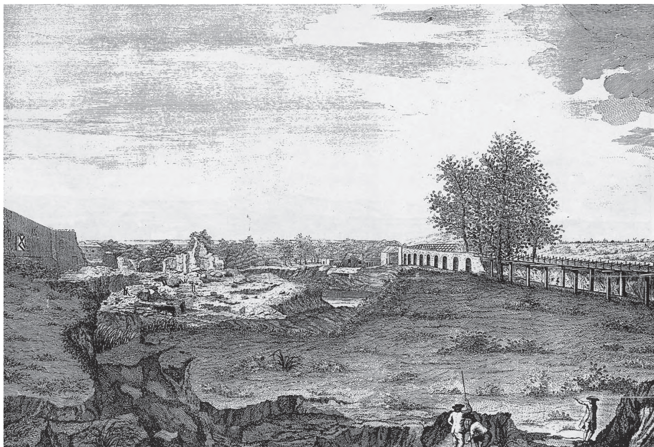
Fig. 6 - Rottura apertasi in Polistena in località "Giuseppina" ampiamente descritta dal Sarconi. Sullo sfondo si nota l'acquedotto che è stato distrutto in più parti; ancora oggi ne sono visibili i resti. - Wide trench opened in Polistena in the "Giuseppina" district, amply described by Sarconi. In the background can be noted the aqueduct that was destroyed in many parts; the remains can still be seen today.
