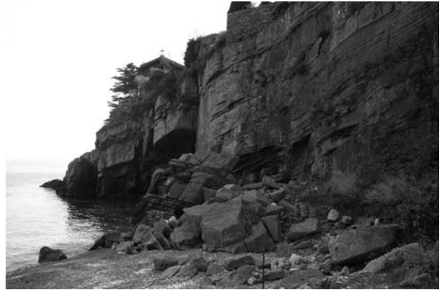
Fig. 14 – Rock fall phenomena on southern cliff of Tino Island. – Fenomeni di crollo nella falesia meridionale dell'Isola di Tino.
