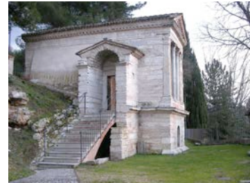
Veduta frontale e laterale del Tempietto del Clitunno. Il colonnato è realizzato con fature e rocce diverse
