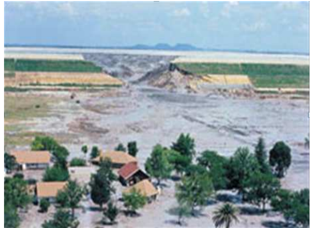
Figura 3.12 Il disastro di Merriespruit (Sud Africa, 1994): la rottura dell'argine per il contenimento dei residui di lavorazione dell'oro travolse un quartiere della cittadina di Merriespruit, provocando la morte di 17 persone e ingenti distruzioni (immagine tratta dal sito web http://www.stava1985.it ).
