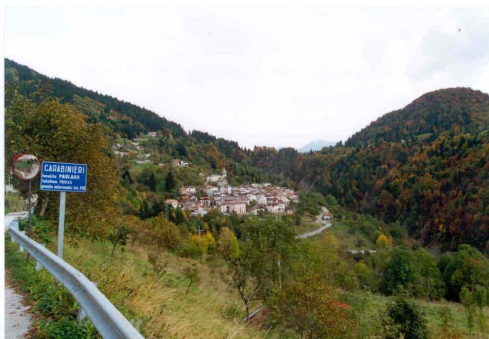
Figura 11.23 Dissesto 0300500100, Comune di Ligosullo (Udine). Veduta panoramica dell'area.
