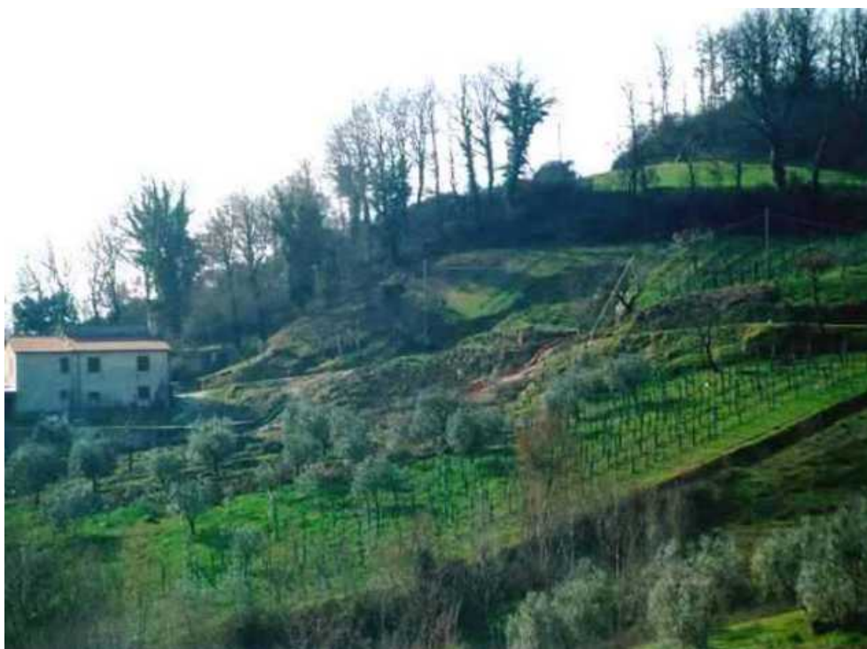
Figura 15.19 Frana di scivolamento in località Colle Pizzuto, Sangemini (TR).
