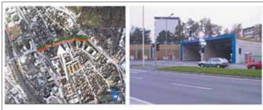
Figura 5: Posizione del tunnel di Graz ed ingresso orientale del medesimo.
