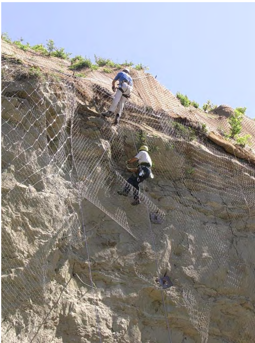
Figura 9.18: Interventi strutturali (reti paramassi) per la mitigazione del rischio idrogeologico nel comune di Fontanelice (BO) 19
