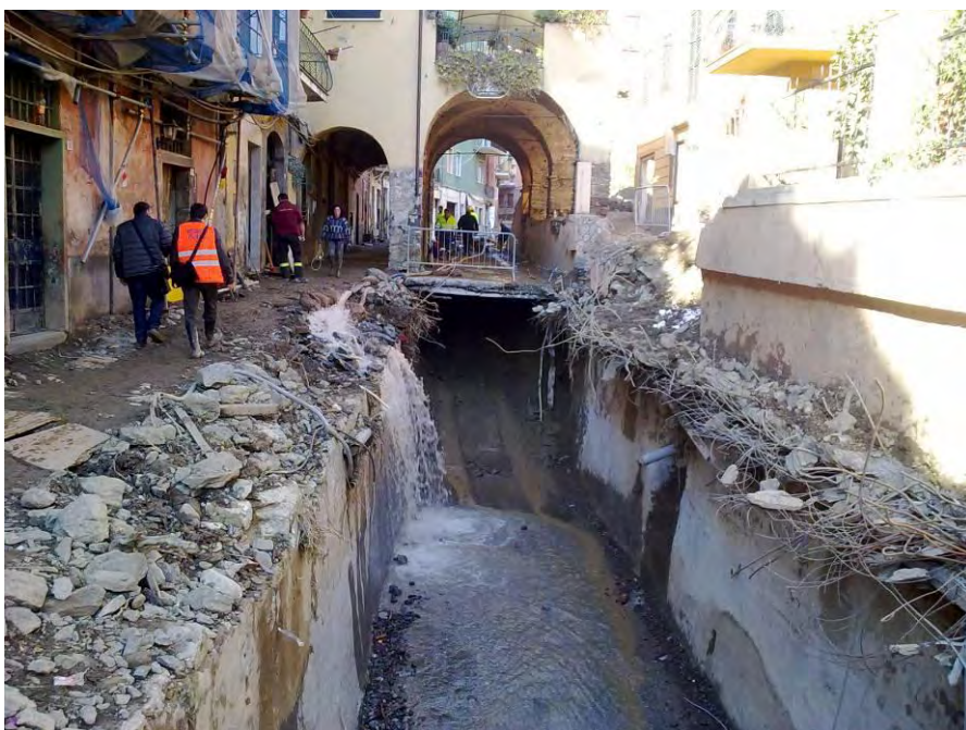
Figura 9.15: Danneggiamenti della sede stradale di via Roma (comune di Monterosso al Mare - SP), sotto la quale scorre il "canale Pastanelli" 16
