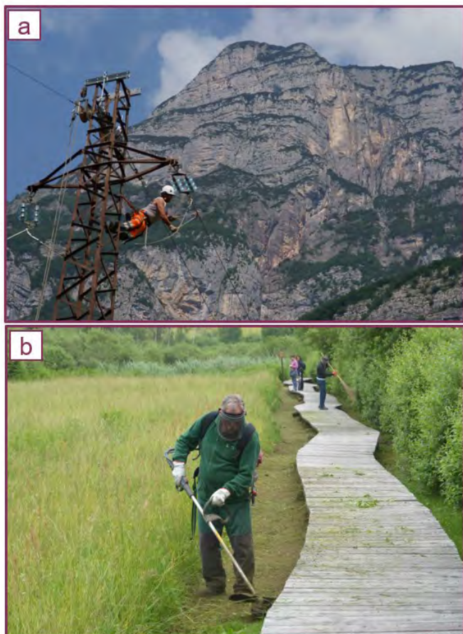
Figura 5. Esempi di interventi di gestione: (a) messa in sicurezza di impianti di media tensione (MT) a cura della Rete di Riserve di Cembra e del Parco Fluviale della Sarca (foto di D. Bassan); (b) manutenzione ordinaria della sentieristica a cura del Parco Fluviale della Sarca (foto di P. Flamini).
