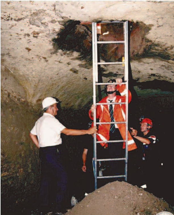
Fig. 7 - Castel Sant'Angelo: nel 1997 fu trovato un cunicolo sotterraneo in seguito alla formazione di una voragine in superficie. - Castel Sant'Angelo: in 1997 it was found an underground tunnel following the formation of a sinkhole.
