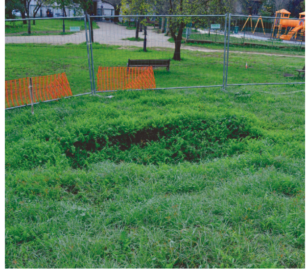
Fig. 8 - Evento di sprofondamento presso Parco Rabin, Villa Ada, quartiere Salario. - Sinkhole in Rabin Park, Villa Ada, Salario district.
