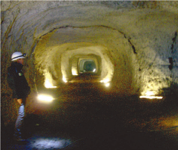
Fig. 13 – Reticolo caveale presso Via di Tor Fiscale. - Underground net in Via di Tor Fiscale, Tuscolano district.
