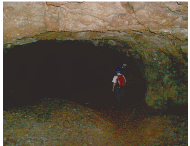
Fig. 9 - Zona Celio. Sotterranei presso il Tempio di Claudio, è presente una vasta area allagata. - Zone Celio. Underground at the Temple of Claudius, is a large area flooded.
