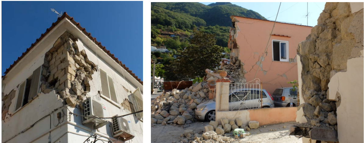
Figura 20 - A sinistra, muratura a doppia parete in blocchi squadrati di tufo con ampi spazi vuoti e malta quasi assente; a destra, muratura in blocchi di tufo etero metrici e di forma sub arrotondata.
