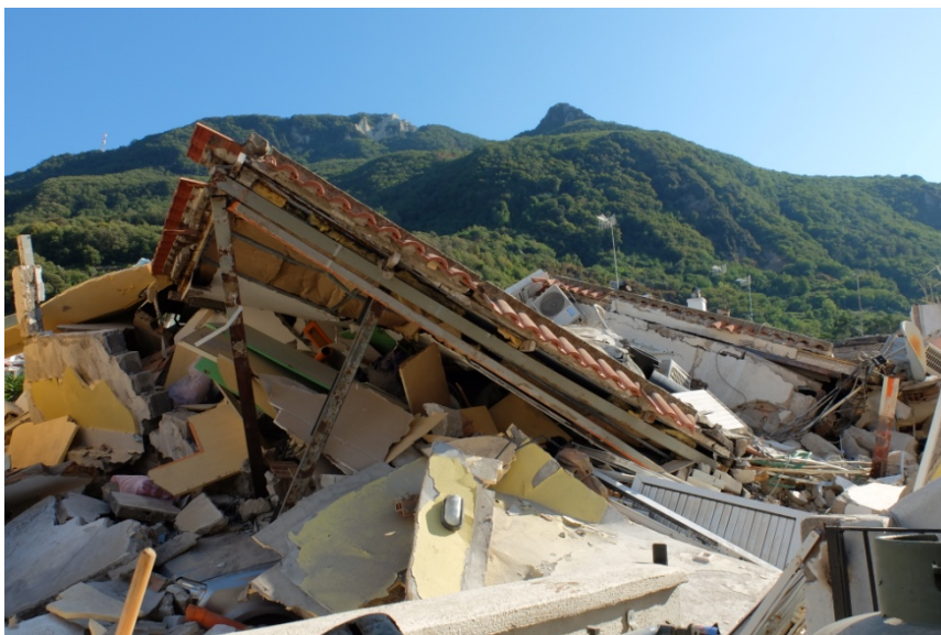
Figura 26 - Area di forte danneggiamento, nel centro abitato di Majo. L'elevata vulnerabilità delle strutture ha giocato un ruolo fondamentale per l'entità del danno.
