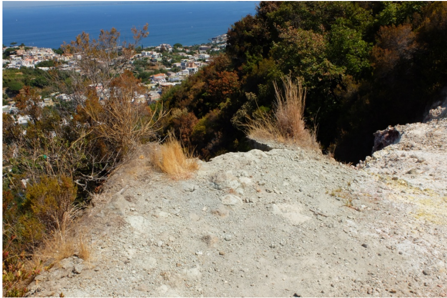
Figura 12 - Margine della scarpata presente in corrispondenza della fumarola (WP330), da cui si è verificato un crollo di un settore della larghezza di circa 70cm; il settore a monte risulta detensionato per una fascia di circa 1-2 metri e pertanto potenzialmente instabile
