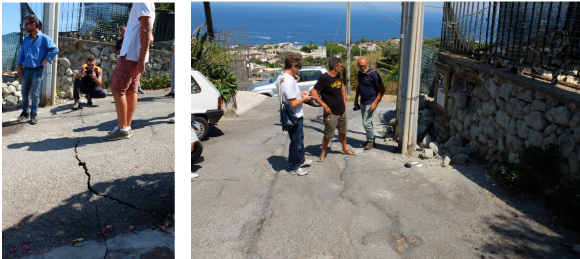
Figura 6 – La frattura trasversale alla via Crateca (WP287), mostra apertura di 1-2cm e rigetto minore di 1 cm verso valle; la frattura è stata monitorata con un vetrino artigianale e non ha mostrato segni di evoluzione fino al 25 agosto.
