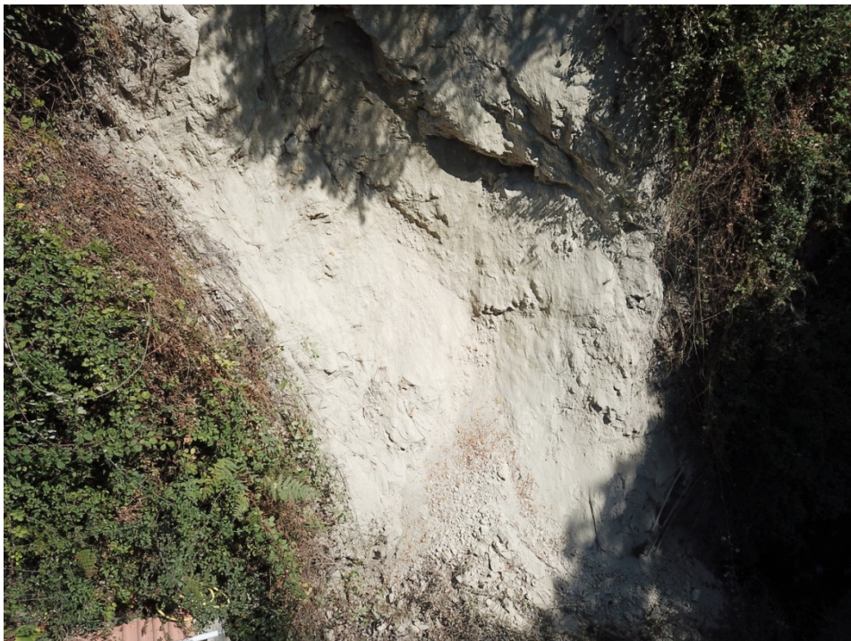
Figura 13 - Distacco di materiale tufaceo avvenuto lungo la scarpata in destra idrografica del Vallone Senigallia, per un volume complessivo di circa 50-60mc.
