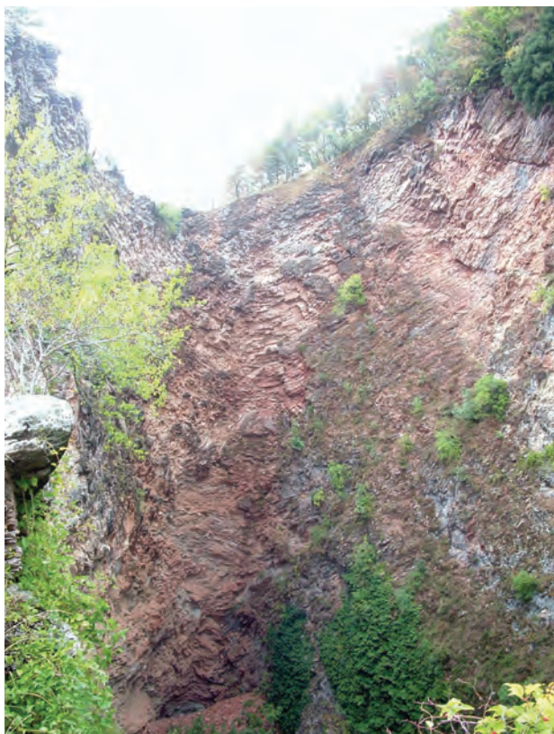
Fig. 33b – Il Pozzo del Larnaro: particolare dell'interno. - The Pozzo del Larnaro: detail of the inner.
