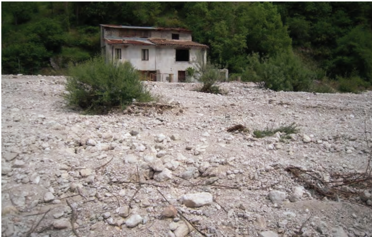
Fig. 19 – Alluvionamento delle aree esterne al letto del T. Scura in occasione dell’evento del dicembre 2010. - Flooding of the external areas of the T. Scura riverbed, during the December 2010 alluvial event.
