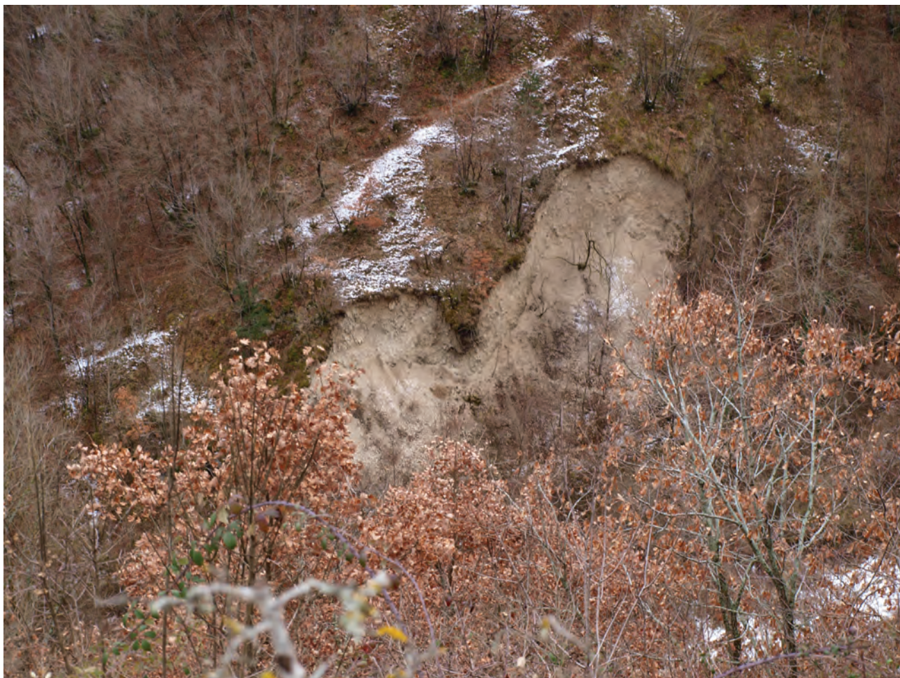
Fig. 31– Frane da scivolamento nei depositi di copertura innescate dalla azione di erosione alla base del versante, del Torrente Scura. - Debris slide triggered by fluvial erosion at the foot of slope in Scura Valley.
