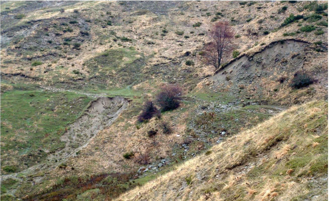
Fig. 29 – Frane da scivolamento traslativo e frane da colata nella facies pelitica alterata della formazione del Flysch della Laga. - Soil slip and compound landslides in weathered silty facies of Flysch della Laga formation.
