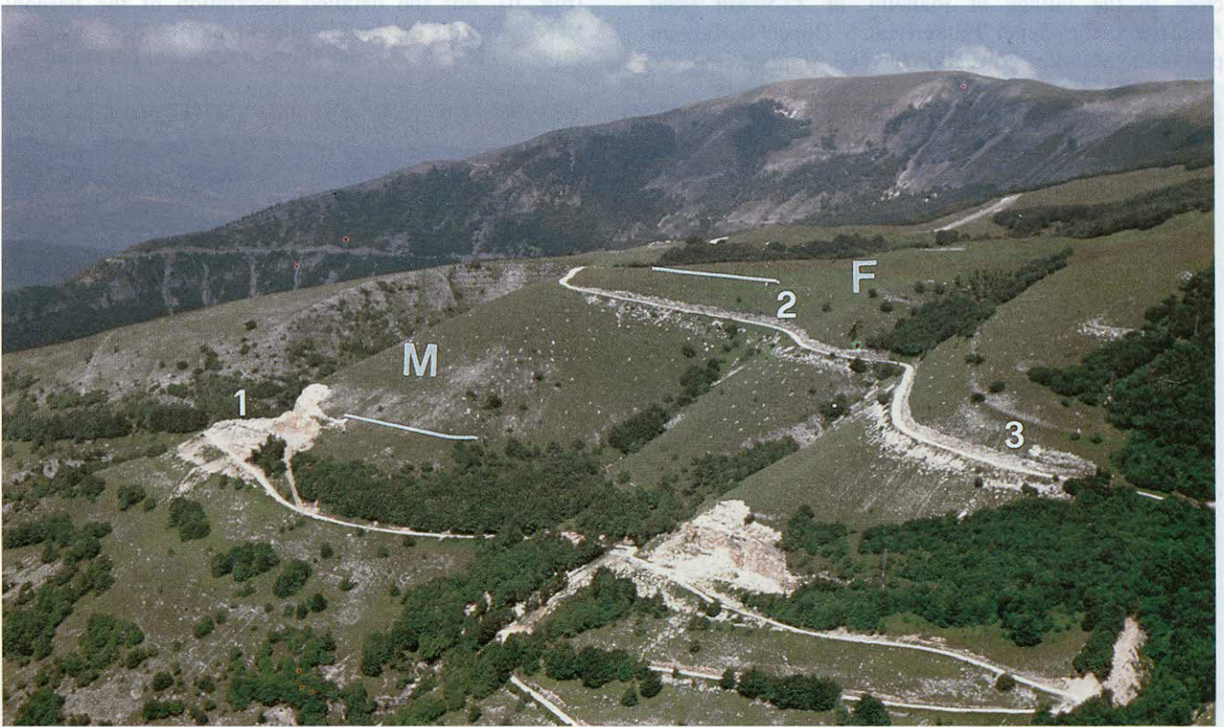
Fig. 5 - View of the quarries opened in the southern flank of Monte Nerone. M: Maiolica; F: Marne a Fucoidi. 1) Bugarone quarry; 2) Silesites bearing beds; 3) Faraoni Level. - Vista delle cave aperte nel versante meridionale di Monte Nerone. M: Maiolica; F: Marne a Fucoidi. 1) cava del Bugarone; 2) strati con Silesites ; 3) Livello Faraoni.
