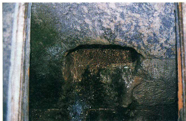
Fig. 7. – Acqua di S. Clemente: condotto romano dal quale fuoriesce l'acqua della sorgente.
