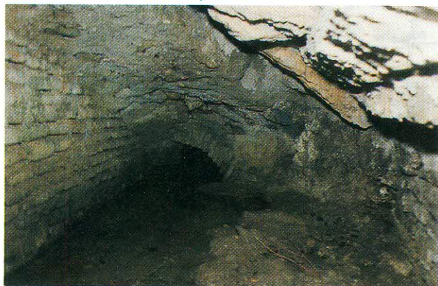
Fig. 4. – Sorgenti Corsiniane: cunicolo romano di captazione. – Corsiniane Sources: roman cuniculus of getting.
