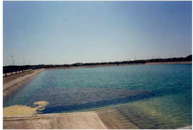
Fig. 4.70 - Vasca di raccolta delle acque, oggi pompate e stoccate dalla sorgente Idume.
