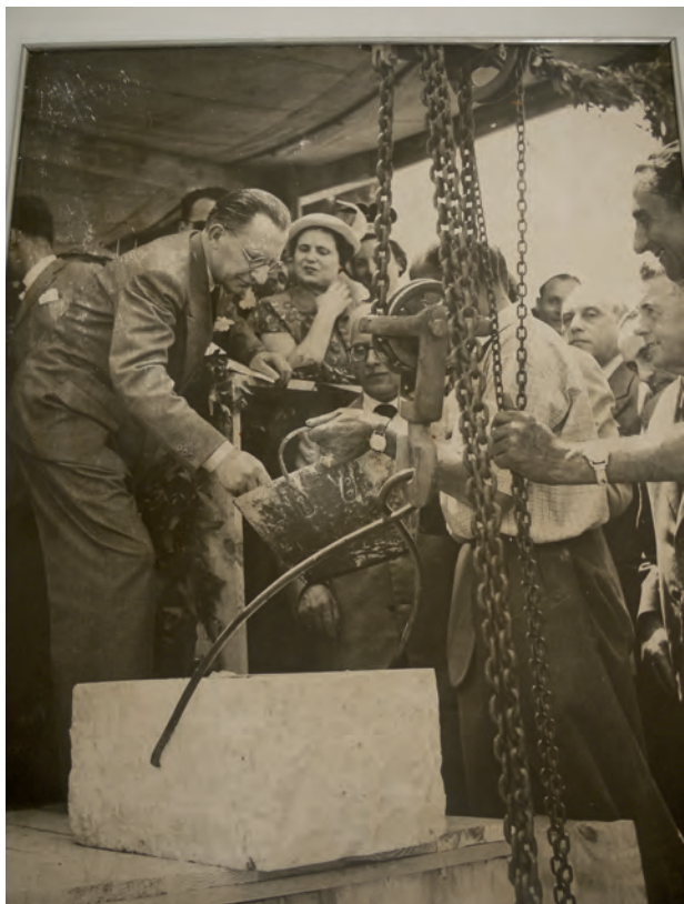
Fig. 4.36 - Il Presidente del Consiglio Alcide De Gasperi dava l'avvio ai lavori mirati all'impiego della sorgente Tara nel 1951.
