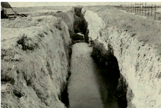
Fig. 4.69 - Trincea attingente l'acqua sotterranea della sorgente Idume in uno scavo in pietra leccese eseguita nei primi lavori progettati per l'impiego delle acque sotterranee dell'Idume unite ad acque reflue trattate.
