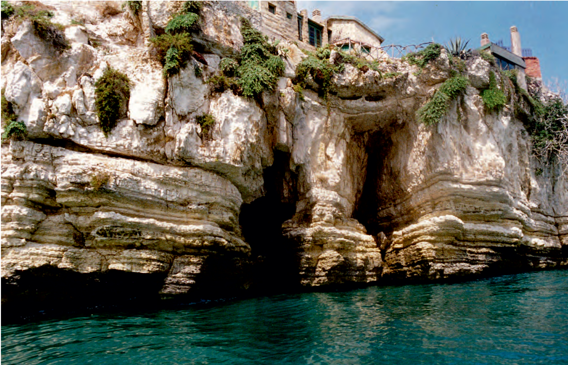
Fig. 13.44 - Veduta dal mare della falesia di Vieste. Alla base risalta l'erosione al piede che coinvolge la Formazione dei Calcarei di tipo "scaglia" (Cretaceo sup.), costituita da calcari micritici debolmente marnosi, in strati sottili e medi intervallati da straterelli a liste e noduli di selce. La porzione sommitale della falesia è costituita da calcareniti bioclastiche a strati medio-spessi della Formazione a nummuliti di Peschici (Eocene). Il contatto di tipo trasgressivo mostra chiaramente sulla parete la discordanza angolare tra gli strati delle due formazioni.
