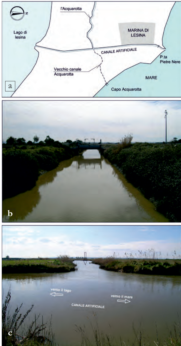
Fig. 13.35 - Canale artificiale Acquarotta: a) attuale tracciato del Canale, collegante il lago di Lesina con la foce a mare alla Punta delle Pietre Nere; b) ripresa del Canale dal ponte a sud in direzione sud; sullo sfondo la paratoia; c) confluenza del canale Acquarotta naturale in quello artificiale. - Acquarotta artificial channel: a) current layout of the channel connecting the Lesina Lake with the outlet to the sea at Pietre Nere; b) upstream view of the channel from the bridge to the South, showing the gate in the background; c) confluence of the natural Acquarotta channel into the artificial one.
