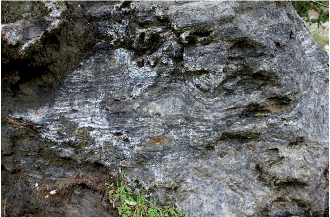
Fig. 13.22 - Degrado idrogeologico e geotecnico dei gessi (selenite) lungo le sponde del canale Acquarotta a causa del fenomeno di dissoluzione carsica. - Hydrogeological and geotechnical degradation of gypsum (selenites), caused by karst dissolution, along the banks of the Acquarotta channel.
