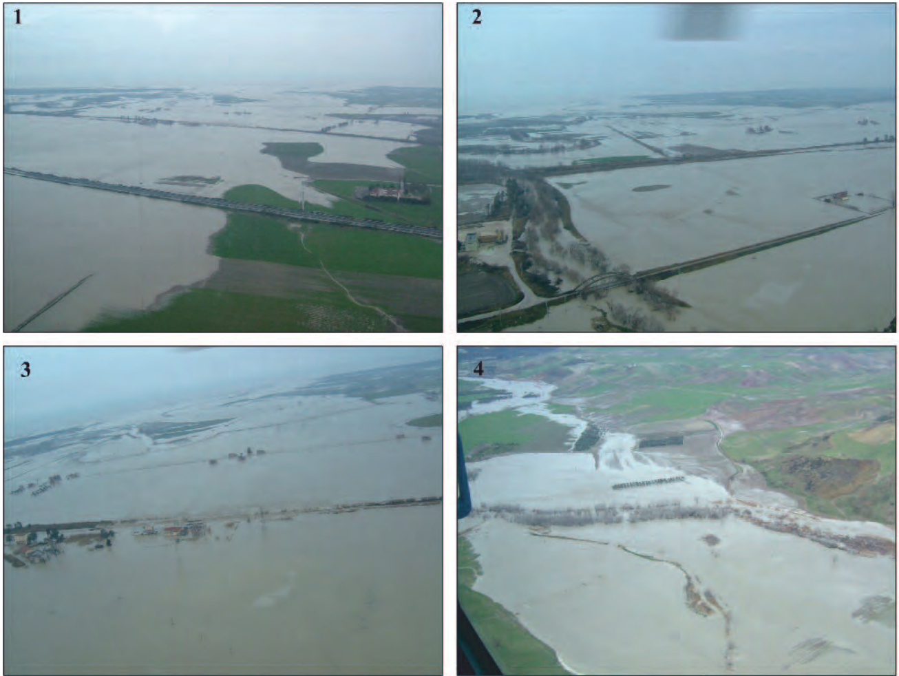
Fig. 14.19 - Foto degli allagamenti scattate il 5 Marzo 2005, l'ubicazione è indicata in figura 14.18 (ex Genio Civile, Foggia). - Photos of the floods, taken on 5 March 2005 the location shown in figure 14.18 (ex Genio Civile, Foggia).
