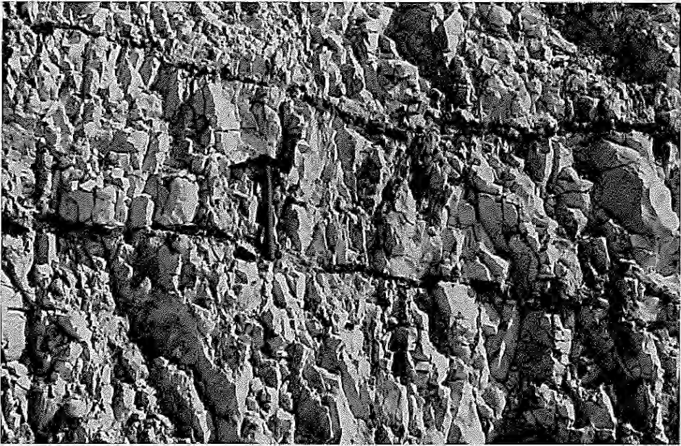
Fig. 9 — Calcari bianchi a grana fina con selci, permeabili per fessurazione, affioranti a Testa del Gargano.
