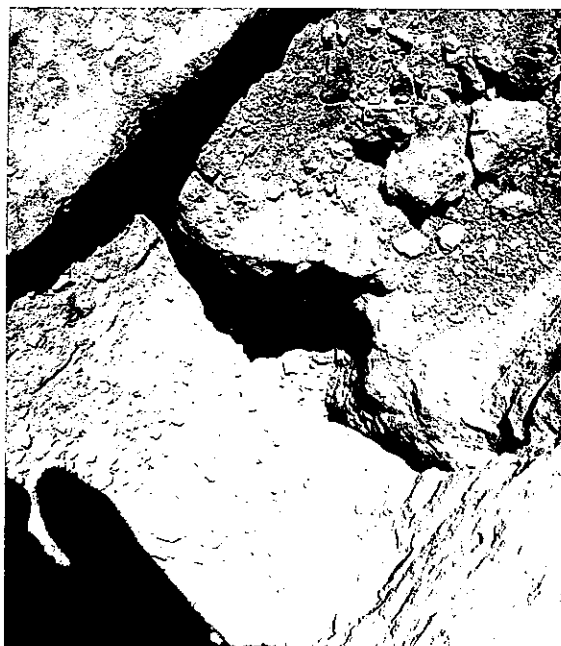
Fig. 13 — Grosse fratture tettoniche, chiaramente elaborate dalle acque di infiltrazione, esistenti nella « Pietra Leccese » (scavi di fondazione dell'edificio del Centro Oncologico Salentino, a sud di Lecce).
