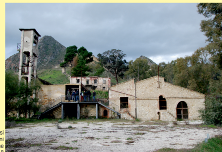
Miniera Museo Cozzo Disi Casteltermini impianto di fusione a vapore dello zolfo, 2018
