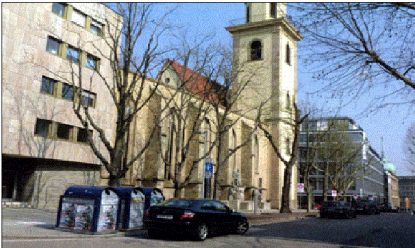
Figura 2: Stoccarda, Hospitalplatz, l'area prima dell'intervento di pedonalizzazione
