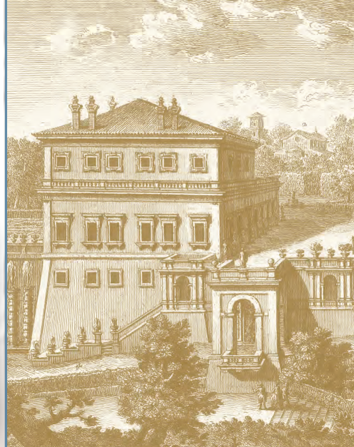
Palazzetto Mattei in Villa Celimontana
